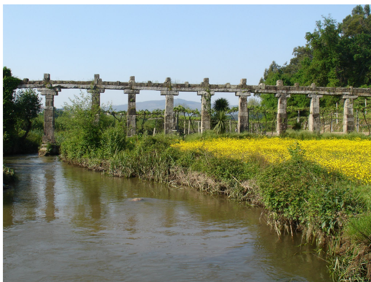
Figura 5 – Aqueduto de Nevogilde.
