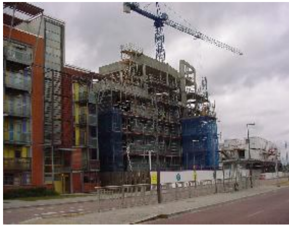
Figura 5.9 – Vista dos aspectos construtivos dos edifícios Greenwich Millennium Village
