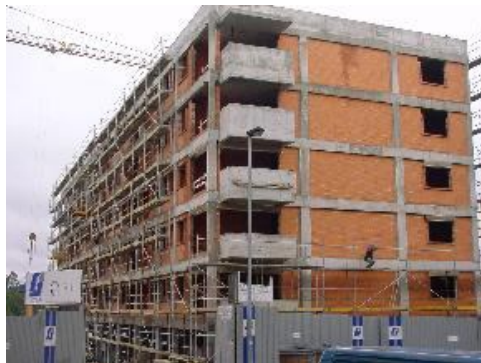
Figura 5.18 – Vista da fase de construção do empreendimento Ponte da Pedra
