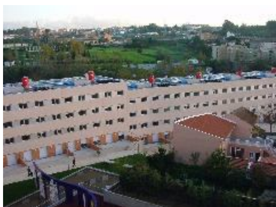
Figura 5.17 – Vista dum pormenor do empreendimento Ponte da Pedra
