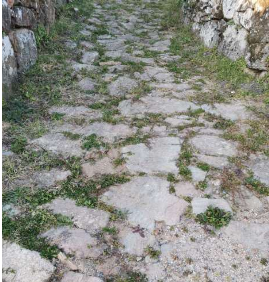
Ilustración 38 Calzada de piedra en Piñeiro (Fuente. Autor)
