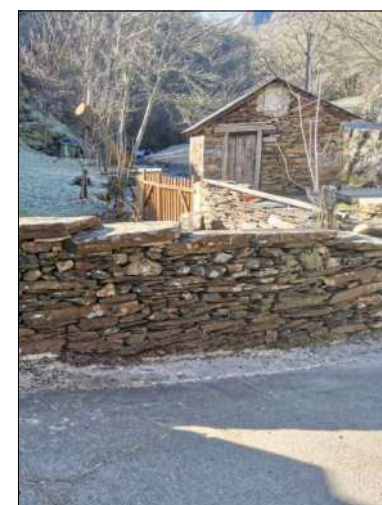
4 Muros/cierres de carácter tradicional
