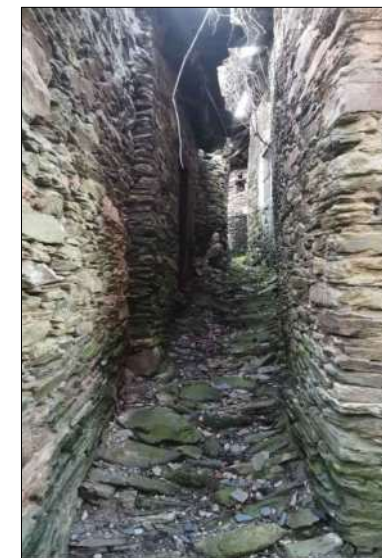
2 Espacio resultante entre edificaciones.
