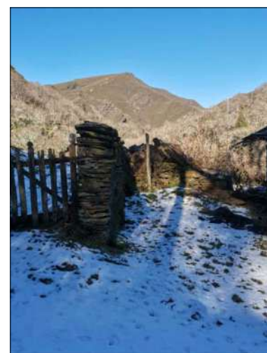
3 Muros/cierres de carácter tradicional
