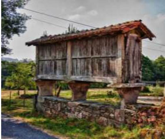
Ilustración 5 Hórreo tradicional sin intervención
