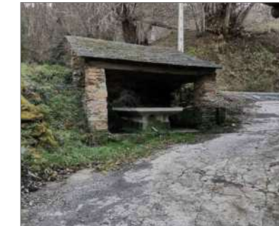
Edificación catalogada bajo el número 732, la cual se corresponde a una fuente-lavadero. Esta construcción tradicionalmente había sido levantada en mampostería de esquistu con cubierta de pizarra. Recientemente la cubierta ha sido intervenida substituyendo el material de cubrición.
