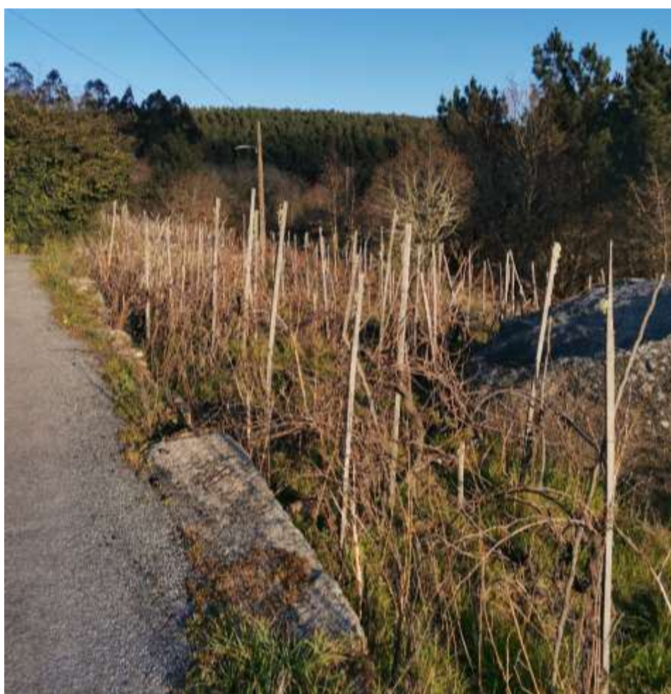
Ilustración 37 Muro bajo en Piñeiro (Fuente Autor)
