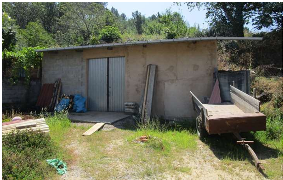
Ilustración 36 Edificación auxiliar emplazada en Suelo de Núcleo Rural de Expansión (Fuente Catastro)
