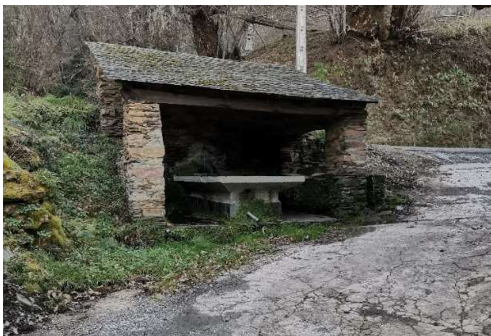
Ilustración 24 Intervención realizada sobre el espacio público en Eiriz (Fuente. Autor)
