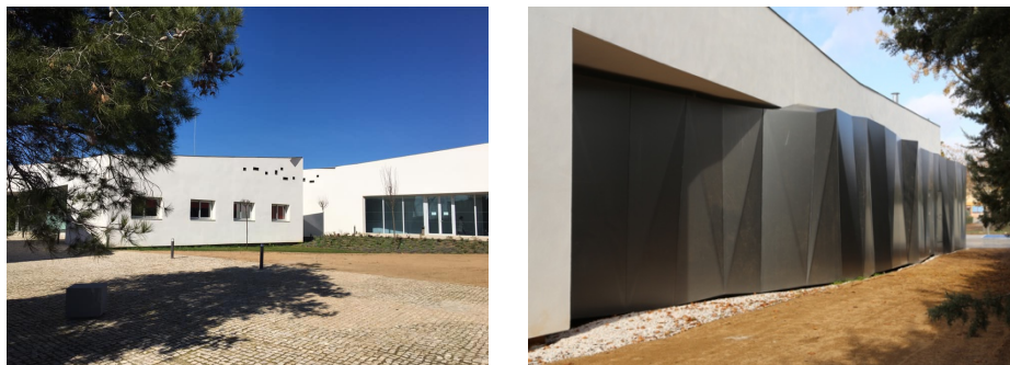
Figura 113 Imagen del exterior del centro. Fuente: B11 Arquitectos
