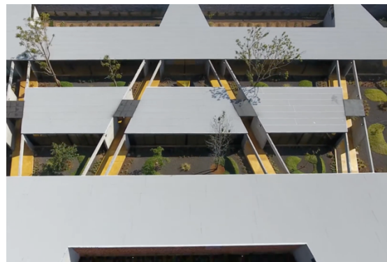
Figura 136 Cubierta y espacio exterior del refugio. Fuente: Arquine.
