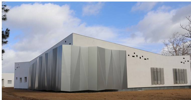
Figura 97 Fachada exterior con chapa metálica. Fuente: B11 Arquitectos
