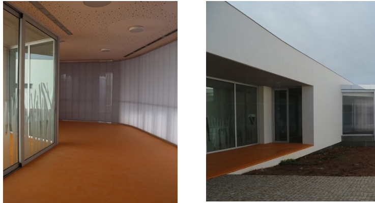
Figura 112 Distribuidor y terraza del proyecto. Fuente: B11 Arquitectos.
