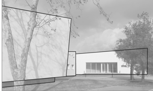
Figura 98 Imagen que resalta las aristas del edificio del centro de la Casa de la mujer y el menor. Fuente: Autoría propia
