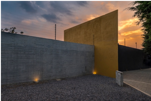
Figura 140 Vista del muro exterior. Fuente: Arquine
