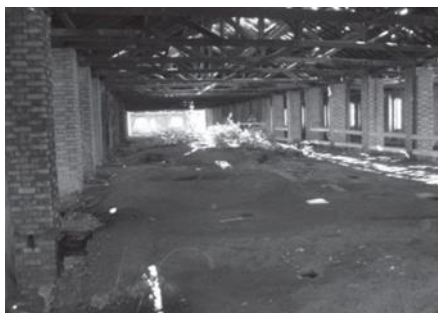
Figura 102: Interior do existente.
