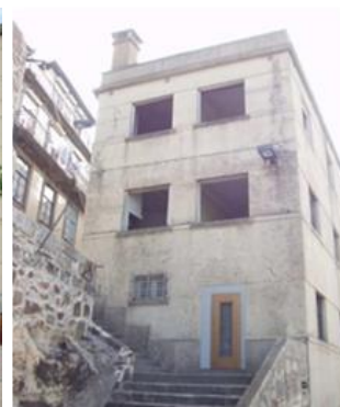
Figura 80: Fachada Poente, 2003. Carlos Prata, Gabinete de Arquitetura.
