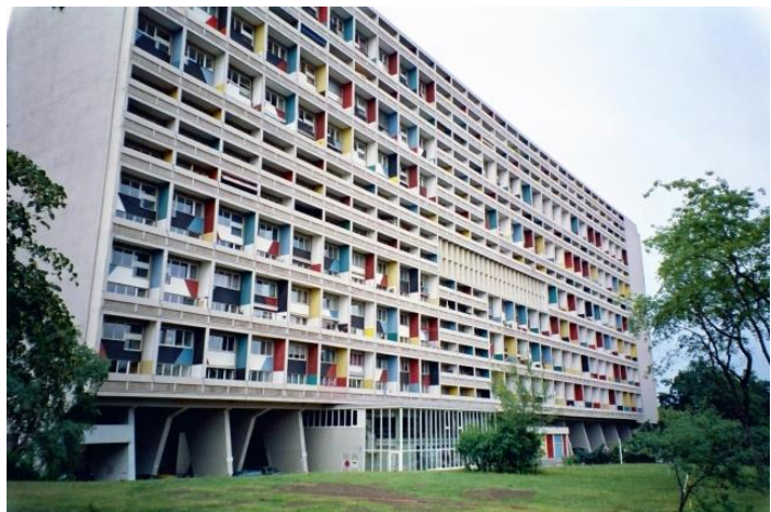
Figura 11: Unidade de Habitação de Marselha. Le Corbusier.
