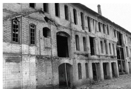
Figura 100: Pormenor da fachada principal do existente da Fábrica de Cerâmica Arganilense
