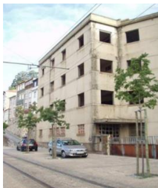
Figura 79: Fachada a Sul, 2003. Carlos Prata, Gabinete de Arquitetura.
