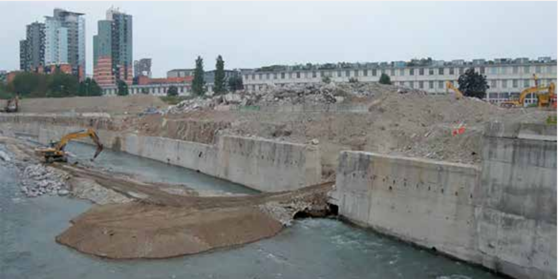
Parco Dora. Intervenção de renaturalização fluvial: remoção de cerca de 3 m de cobertura em betão para reabrir um troço de aproximadamente 1 km do rio. Foto de Claudia Cassatella, 2017.
