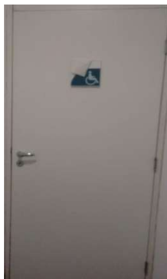
Figura 20 | Entrada do banheiro acessível. Fonte: Dados Primários, 2018.
