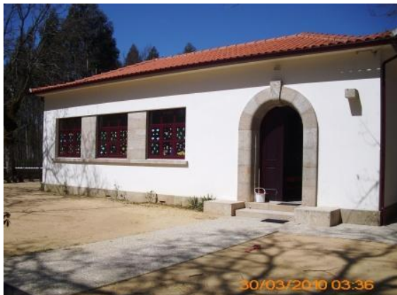
FOTO 21 – ESCOLA NOVA DE FORMARIZ
