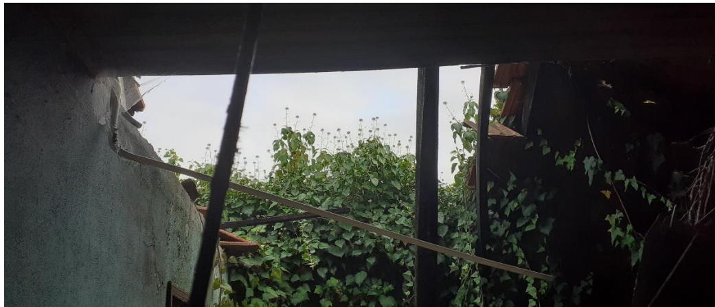
Figura 16 – Fotografia da edificação existente (interior)
