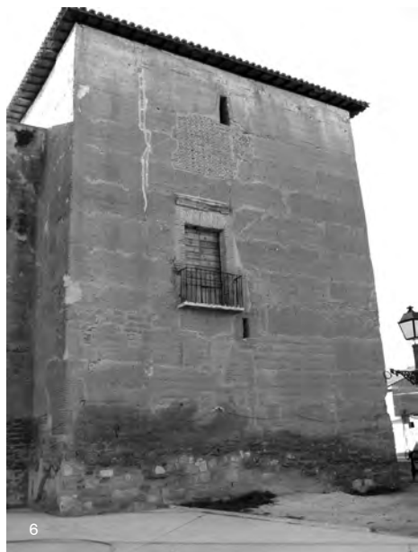
Figura 6: Intervención en vivienda de tapia, Castilla y León, España. Fuente: (Correia, 2011).
