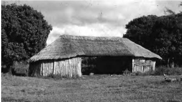
Figura 2: Vivienda rural tipo culata jovai en el Guairá (1982), donde aún se aprecia parte de la tierra del estaqueo. Fuente: Fotografía del autor.
