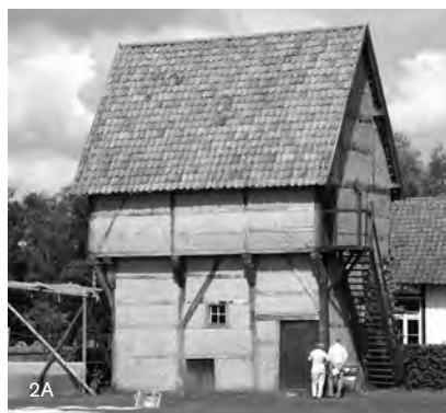
Figuras 2A y 2B: Técnica mixta de encestado integrado en estructura de madera, Museo de Bokrijk, Bélgica. Fuente: (Correia, 2010).
