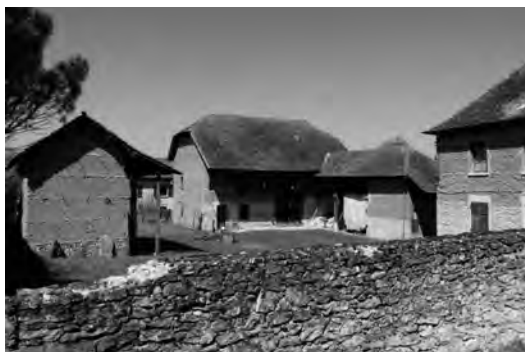
Figura 3: Conjunto de construcciones rurales en el pueblo de Saint Chef. Fuente: (Moriset, 2011. Archivo CRAterre).
