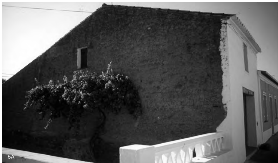
Figura 5A: Vivienda tradicional de tapia, en Telheiro, Reguengos de Monsaraz, Portugal. Fuente: (Correia, 1999).
