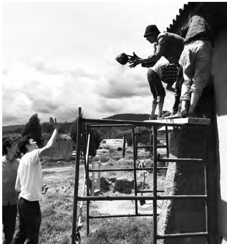
Figura 4: Práctica de construcción con esferas de barro modeladas y posteriormente compactadas. XIV Congreso Internacional de Arquitectura en Tierra. Tradición e Innovación. Tlaxco, Tlaxcala, México. Fuente: Fotografía del autor.
