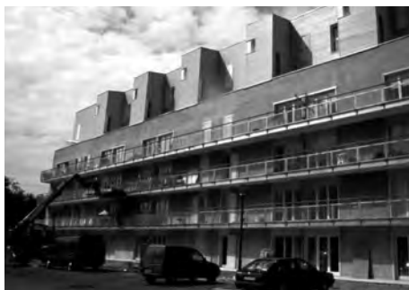
Figura 10: Edificio Salvatierra en Rennes, del arquitecto Barrie, conformado por 43 viviendas y cuya fachada sur es de tapial prefabricado. Fuente: (Archivo CRAterre, 2003).
