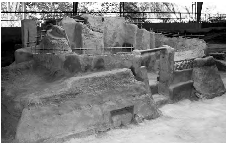
Figura 2: En Joya de Cerén, El Salvador, coexistían técnicas constructivas de bajareque, adobe y tierra modelada, colocadas sobre basamentos de tierra compactada. Fuente: Fotografía del autor.
