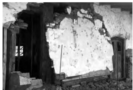
Figura 6: Uno de los muros desplomados por efecto del reblandecimiento de las hiladas inferiores. Fuente: Fotografía del autor.
