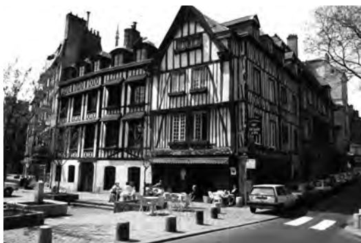
Figura 1: Centro de la ciudad de Rouen, todavía conserva hermosas casas de estructura de madera y torchi . Fuente: (Joffroy, 1991. Archivo CRAterre).
