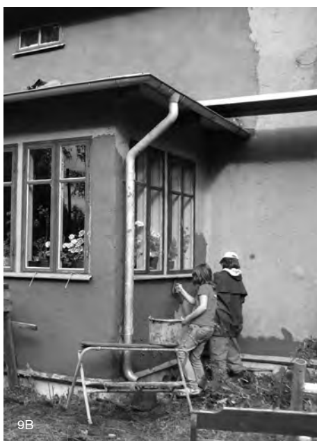
Figuras 9A y 9B: Oficina con revoque de tierra, en Vekhyttan, Suecia. Fuente: (Correia, 2010).
