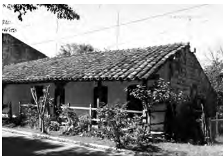
Figura 5: Vivienda en Caapucú, defendida por un muro "cáscara" exterior. Fuente: Fotografía del autor.
