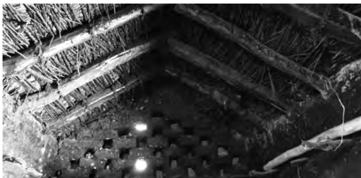
Figura 10: Estructura interna de techo. Se observa los pares, el forjado de chilca y paja. Fuente: Fotografía de la autora.
