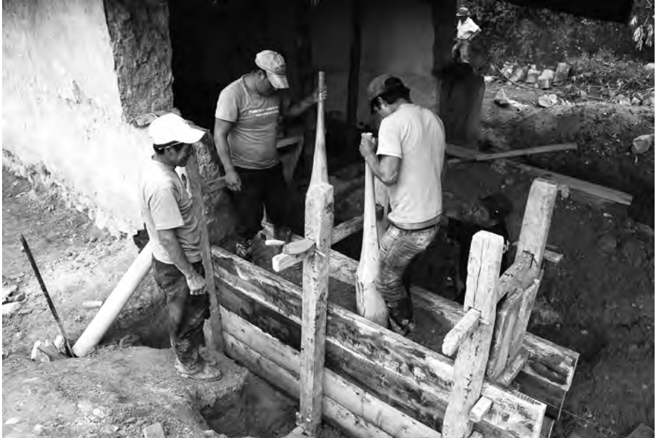
Figura 6: En la construcción de muros de tapia, la tierra requiere estar casi seca. Chuquiribamba, Ecuador. Fuente: Fotografía del autor.
