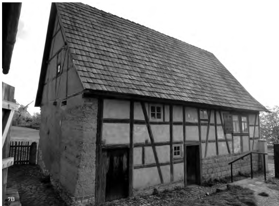
Figuras 7A y 7B: Vivienda con fachada lateral de pared de mano y fachada principal de entramado con encestado. Fuente: (Correia, 2010).
