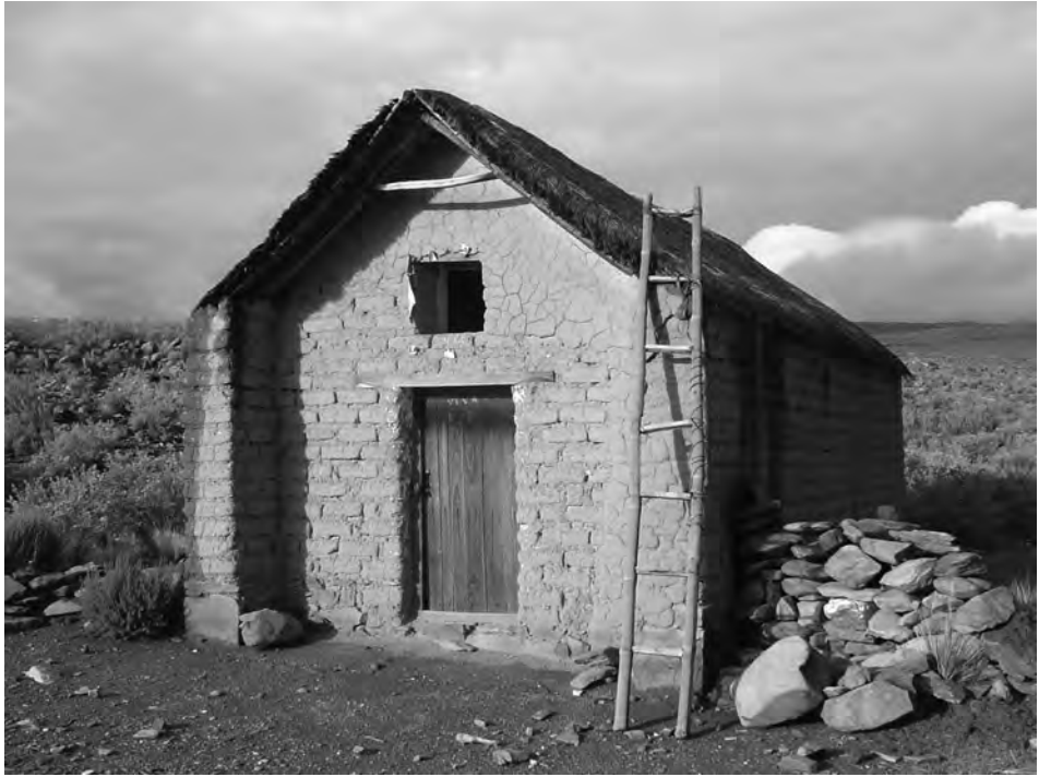
Figura 5: Oratorio en Rinconada, con sus muros en avance que conforman la antecapilla, y la ventana por encima del acceso. Fuente: Fotografía de los autores.
