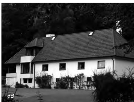
Figura 5B: Vivienda histórica de tapia en Steninge, Suecia. Fuente: (Correia, 2010).
