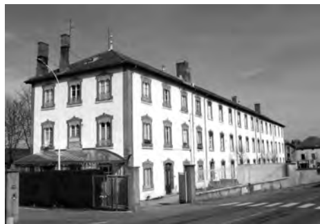
Figura 5: Edificio construido a mediados del siglo XIX en Saint Siméon de Bressieux. Fuente: (Joffroy, 1995. Archivo CRAterre).
