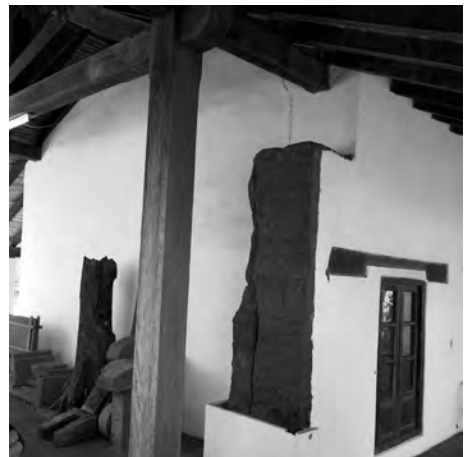
Figura 4: Muro de tipo "tapia a la vista" en San Ignacio Guasú. Fuente: Fotografía del autor.
