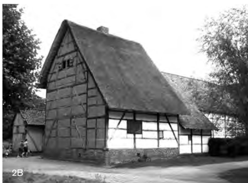
Figuras 2A y 2B: Técnica mixta de encestado integrado en estructura de madera, Museo de Bokrijk, Bélgica. Fuente: (Correia, 2010).
