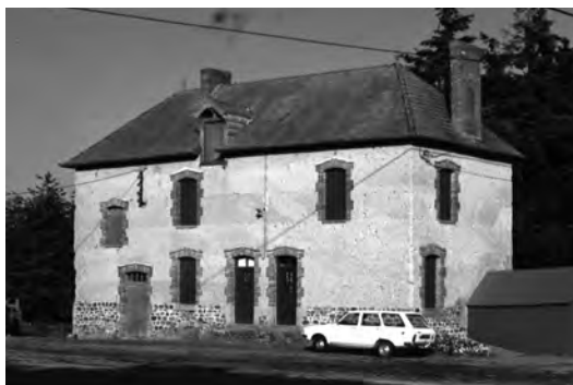
Figura 2: Vivienda de bauge en la periferia de la ciudad de Rennes. Fuente: (Joffroy, 1991. Archivo CRAterre).
