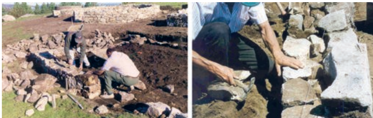
Figura 3. Alinhamento e verticalização dos muros das estruturas.
