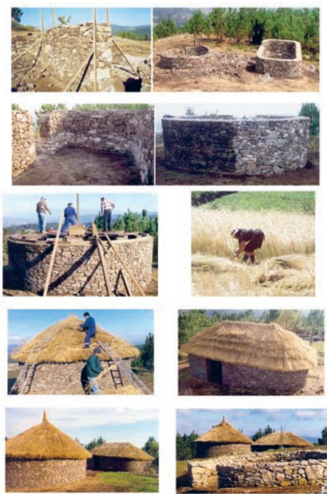
Figura 11. Trabalhos de reconstituição das estruturas habitacionais.
