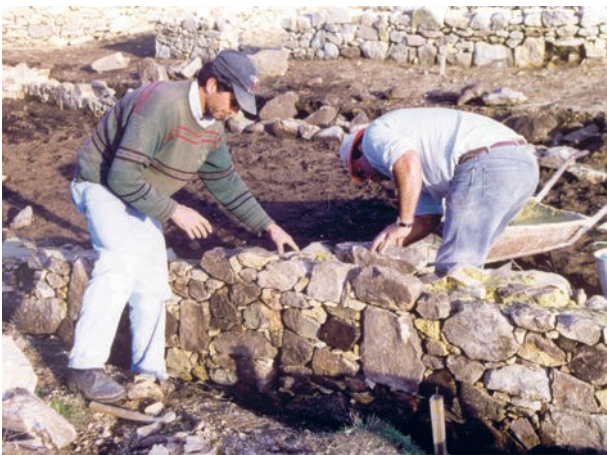
Figura 4. Consolidação dos muros.
