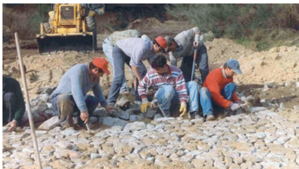
Figura 12. Trabalhos de beneficiação do caminho de acesso.
