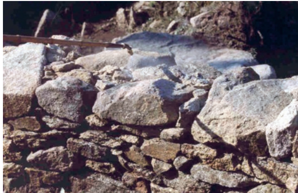
Figura 9. Aplicação de hidrofugante e biocida.
