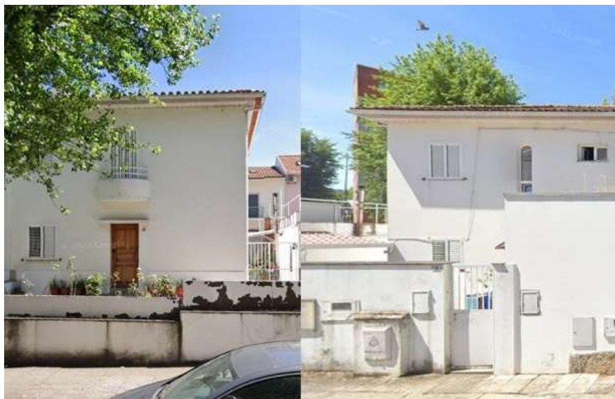
FIGURA 118 - RUA JOÃO BAPTISTA BARBOSA LOPES, CASA 15
