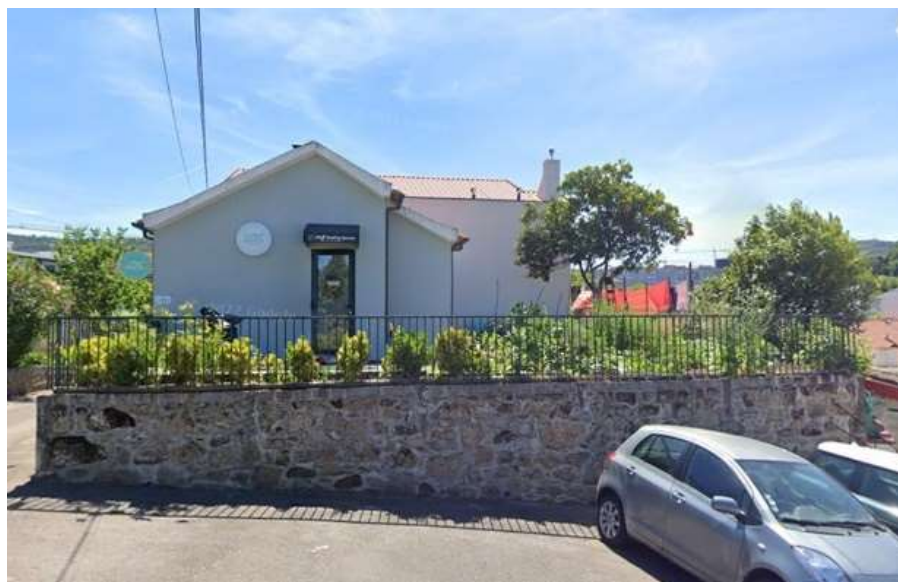
FIGURA 83 - RUA DOS TRABALHADORES, N° 71
