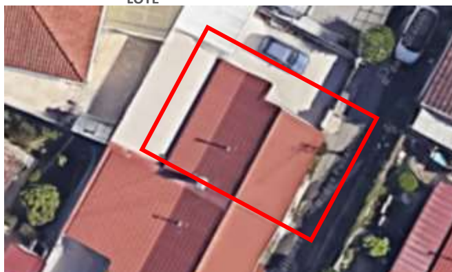
FIGURA 276- CASA 50 – VISTA AÉREA DO LOTE
