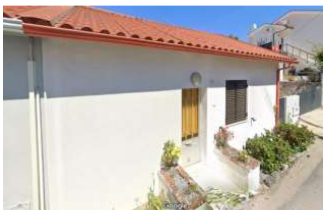
Figura 277 - Casa 50 – Vista frontal
