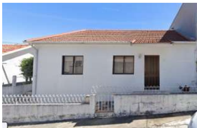
Figura 238 - Casa 37 – Vista frontal
