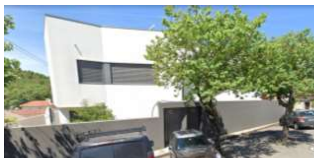
FIGURA 56 - CASA 63 – VISTA FRONTAL
