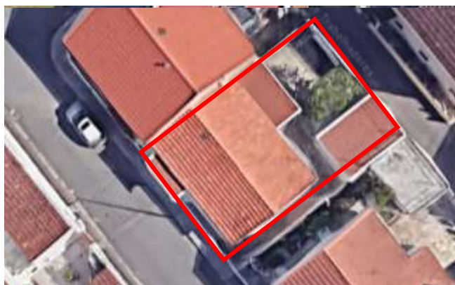
FIGURA 235 - CASA 36 – VISTA AÉREA DO LOTE
