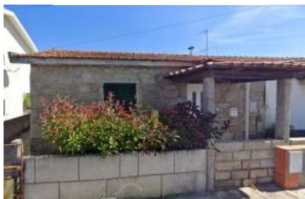
FIGURA 495 - CASA 126 – VISTA FRONTAL
