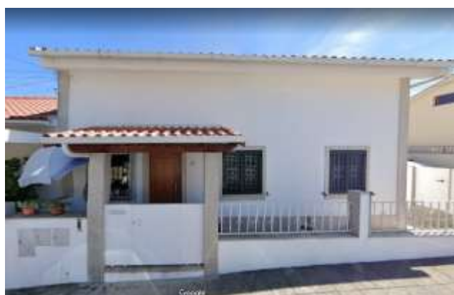
Figura 230 - Casa 34 – Vista frontal
