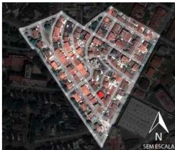
FIGURA 287 - CASA 54 – RUA DR. FRANCISCO MACHADO OWEN
