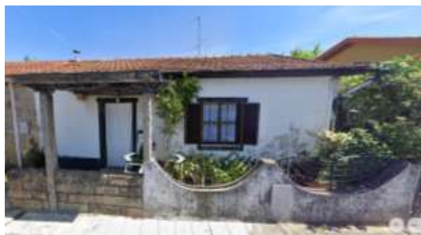
FIGURA 501 - CASA 128 – VISTA FRONTAL
