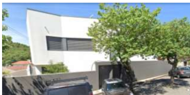
FIGURA 318- CASA 63 – VISTA FRONTAL
