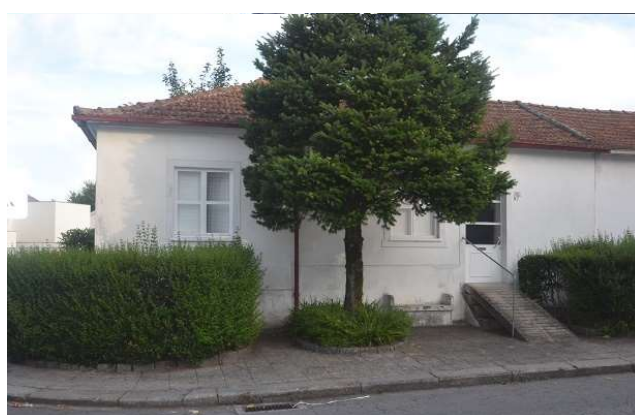
FIGURA 50 - - CASA 41 – VISTA FRONTAL
