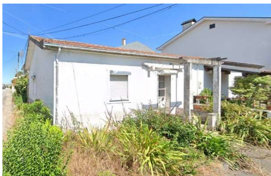
FIGURA 106 - TRAVESSA ROSMANINHO, CASA 110
