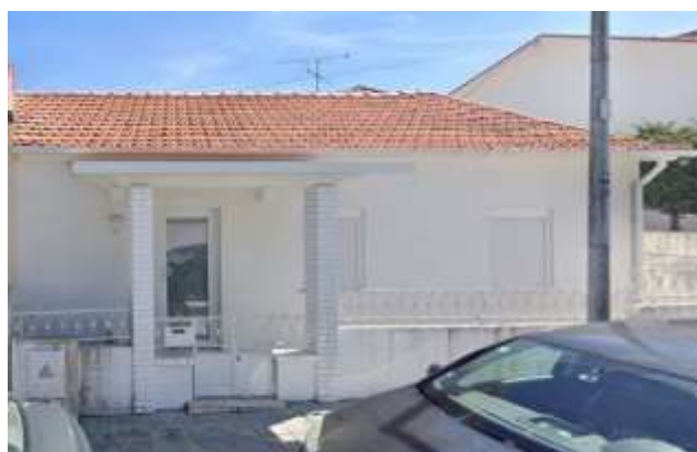
Figura 235 - Casa 36 – Vista frontal
