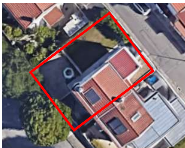
FIGURA 138 - CASA 4 – VISTA AÉREA DO LOTE
