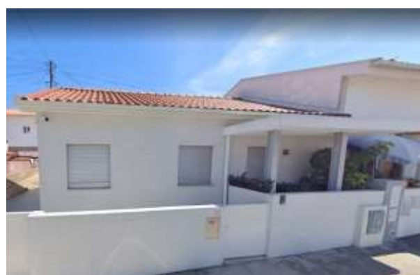
FIGURA 227 – CASA 33 VISTA FRONTAL
