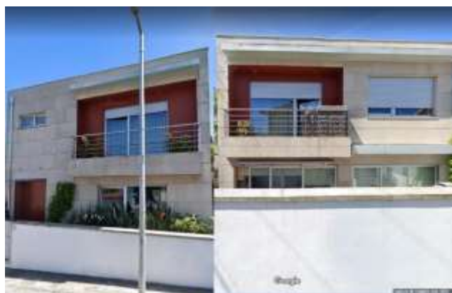
Figura 241 - Casa 38 – Vista frontal
