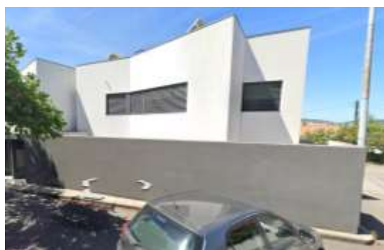
FIGURA 322– CASA 64 – VISTA FRONTAL
