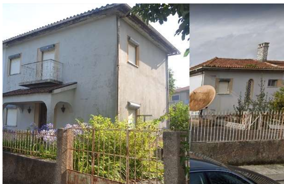
FIGURA 121 - RUA JOÃO BAPTISTA BARBOSA LOPES, CASA 19
