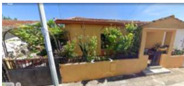
FIGURA 504 - CASA 129 – VISTA FRONTAL
