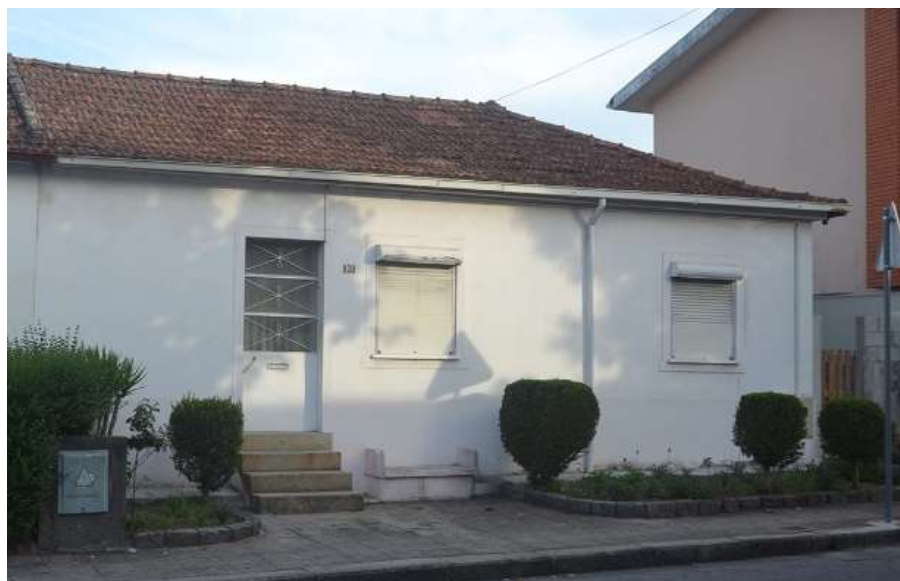
FIGURA 74 - RUA DR. FRANCISCO MACHADO OWEN, CASA 42
