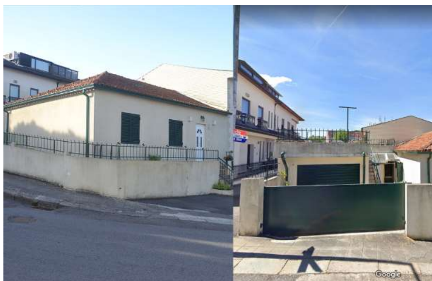
FIGURA 72 - RUA JOÃO BAPTISTA BARBOSA LOPES, CASA 21
