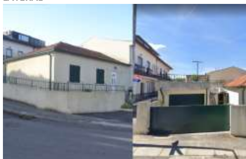
FIGURA 190 - CASA 21 – VISTA FRONTAL E LATERAL
