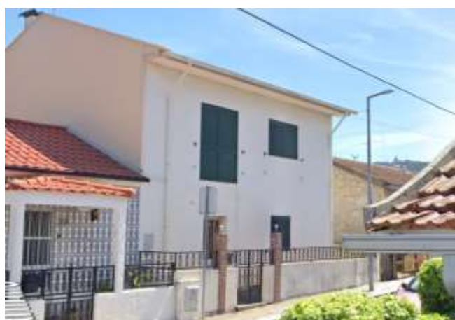
FIGURA 497 - CASA 127 – VISTA FRONTAL
