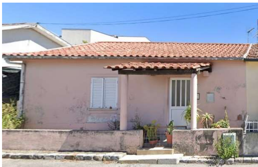
FIGURA 101 - RUA DOS OLIVAIS, CASA 98
