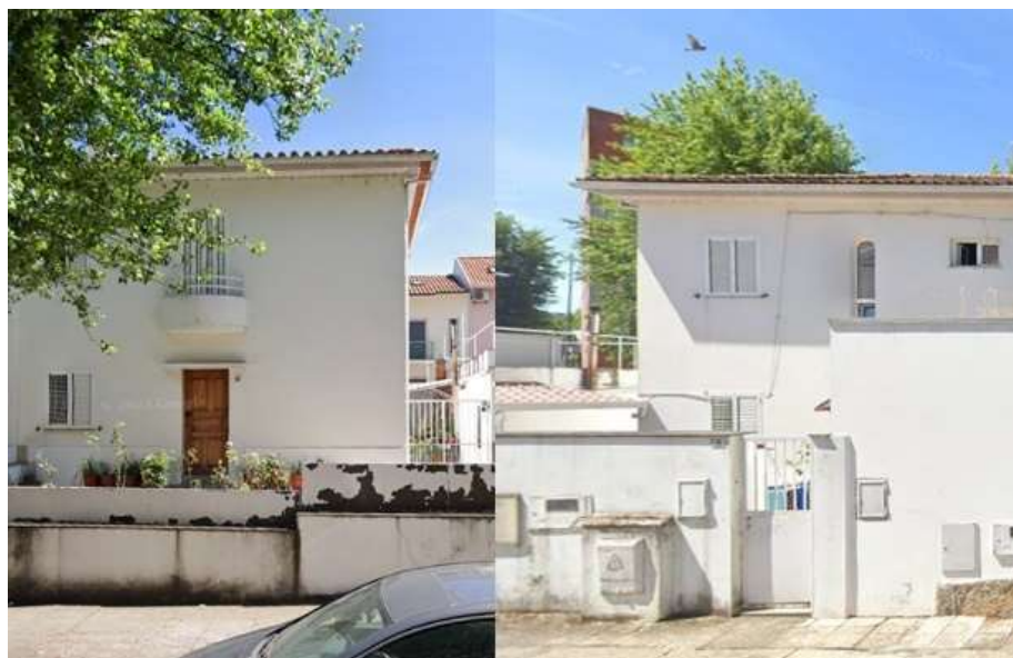
FIGURA 114 - RUA JOÃO BAPTISTA BARBOSA LOPES, CASA 2
