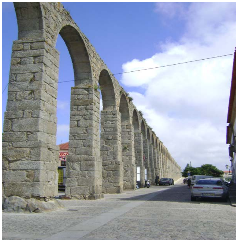
Foto 8: Aqueduto de Vila do Conde (séculos 17 e 18)
