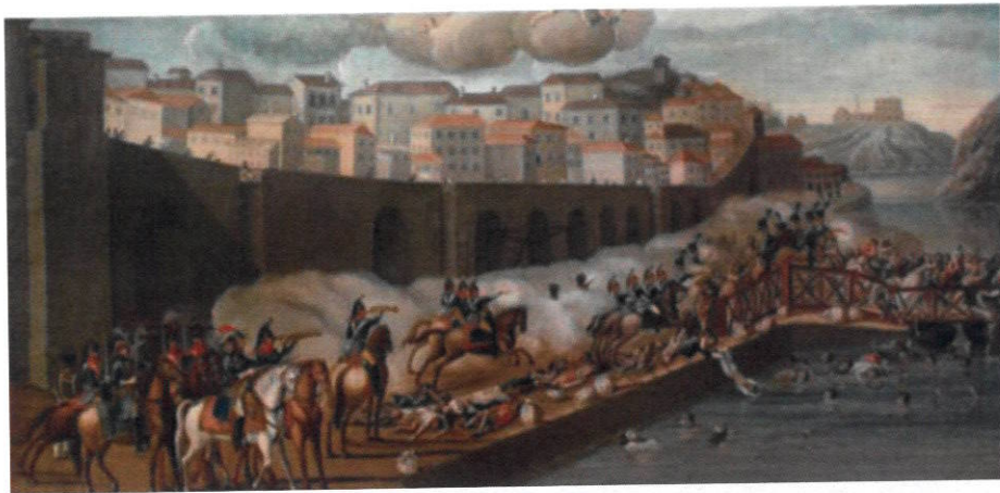
Fig. 3 O desastre da Ponte das Barcas. Pormenor.
