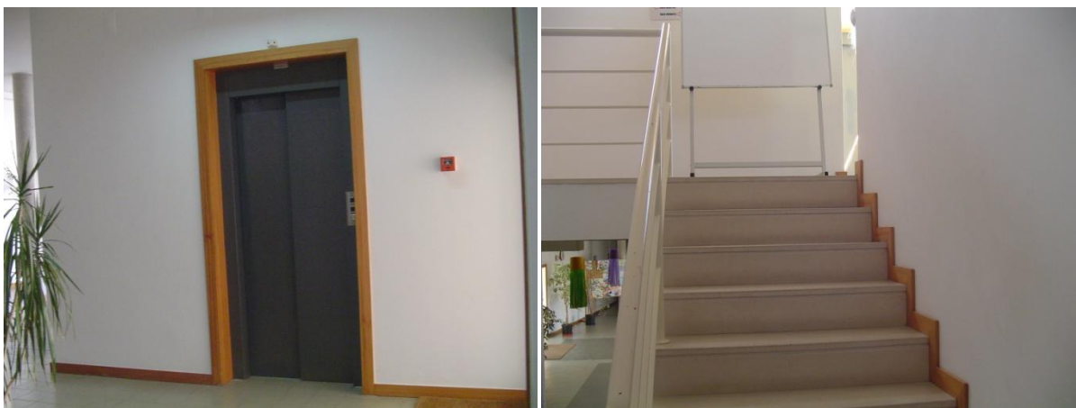
Figura 10 –(Esq) Acesso ao elevador (Dir) Escadas de acesso à biblioteca
