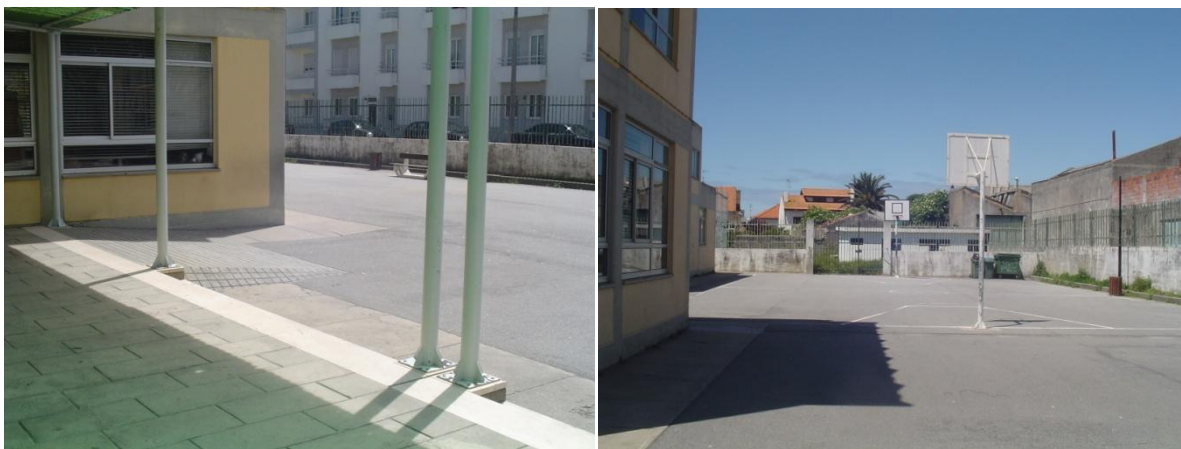
Figura 24 ( Esq ) Rampa de acesso ao edifício (lado poente) ( Dir ) Área de recreio
