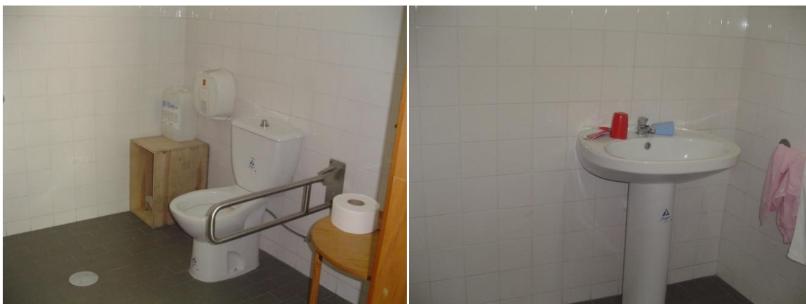
Figura 35 – Instalações sanitárias adaptadas
