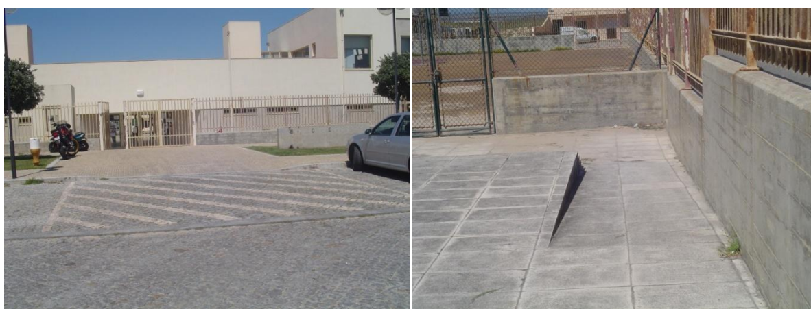
Figura 8 –(Esq) Entrada com passeio rebaixado (Dir) Rampa de acesso ao campo de jogos
