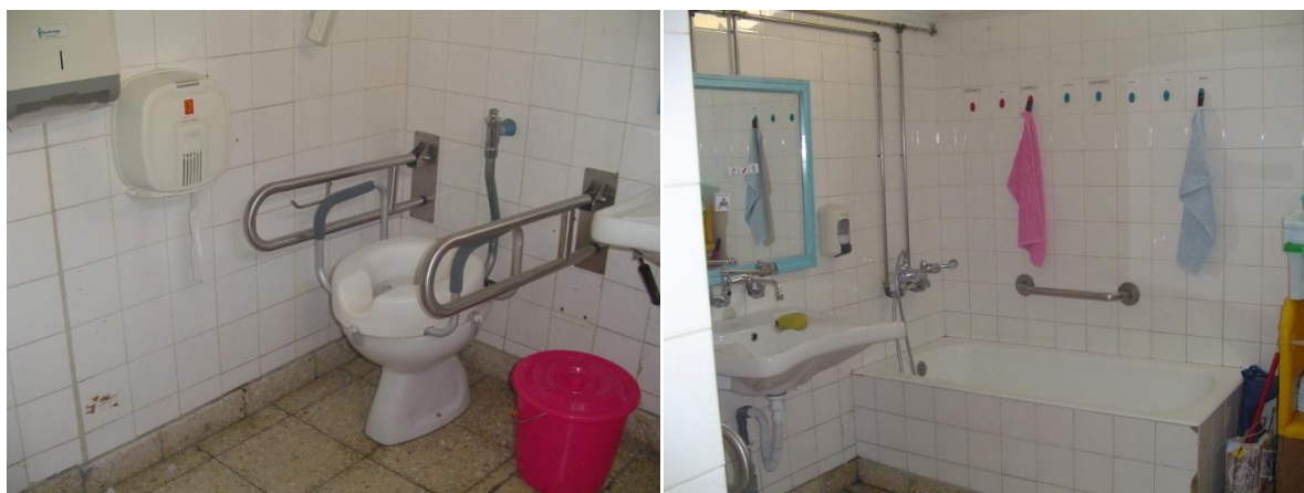
Figura 34 - Instalações sanitárias adaptadas para alunos da unidade de multideficiência
