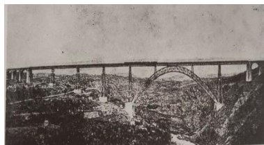
Fig. | 3| Puente de Garabit, del Ingeniero Eiffel (Le Corbusier, 1977).
