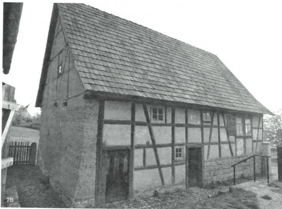
Figuras 7A y 7B: Vivienda con fachada lateral de pared de mano y fachada principal de entramado con encestado. Fuente: (Correia, 2010).
