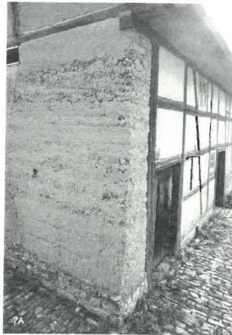
Figura 6: Intervención en vivienda de tapia, Castilla y León, España. Fuente: (Correia, 2011).
