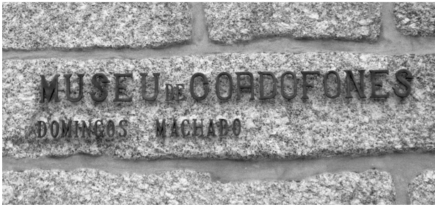
Figura 3 – Pormenor do nome na fachada principal
