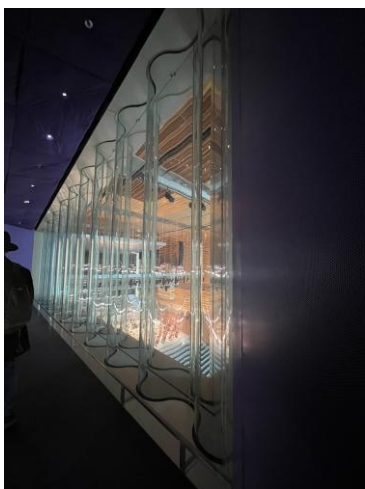
Ilustración 157: Muro cortina interior da sala morada da Casa da Música. Autoría propia
