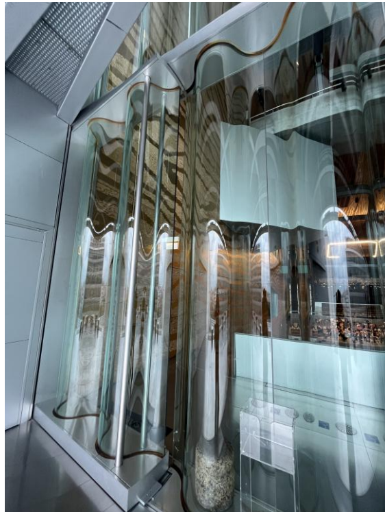
Ilustración 151: Apertura lateral do muro cortina interior da fachada Este da Casa da Música
