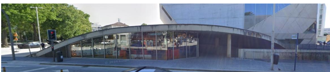
Ilustración 158: Conxunto de ilustracións que mostran os muros cortina con ancoraxe montante e travesaño exteriores da Casa da Música e dun dos seus espazos comerciais
