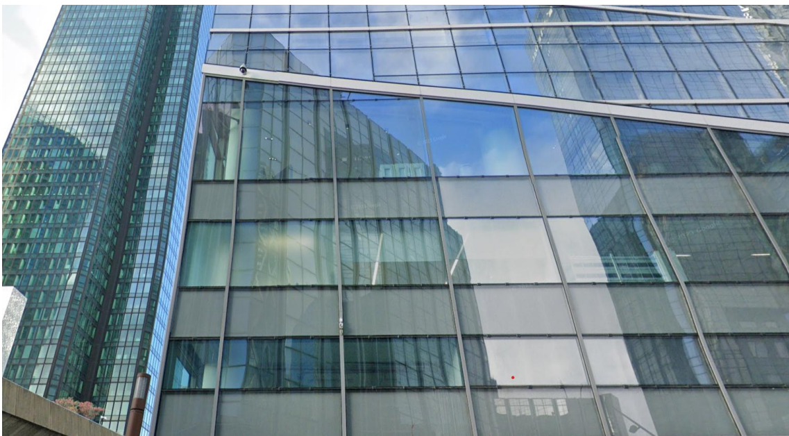
Ilustración 92: Muro cortina bloque central
