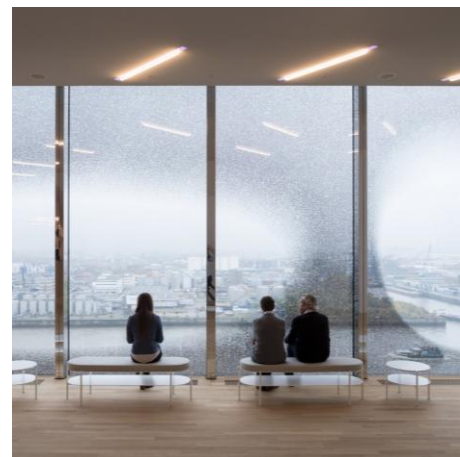
Ilustración 114: Resultado da pigmentación do vidro da Elbphilharmonie
