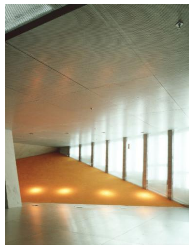
Ilustración 155: Muro cortina interior da sala laranxa da Casa da Música
