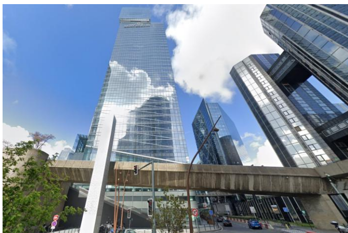
Ilustración 83: Fachada noreste da Tour Saint-Gobain, ponte peonil e escadas
