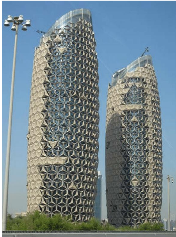
Ilustración 33: Al Bahr Towers, Abu Dhabi, 2009, fachada sombreamento dinámico en 2012
