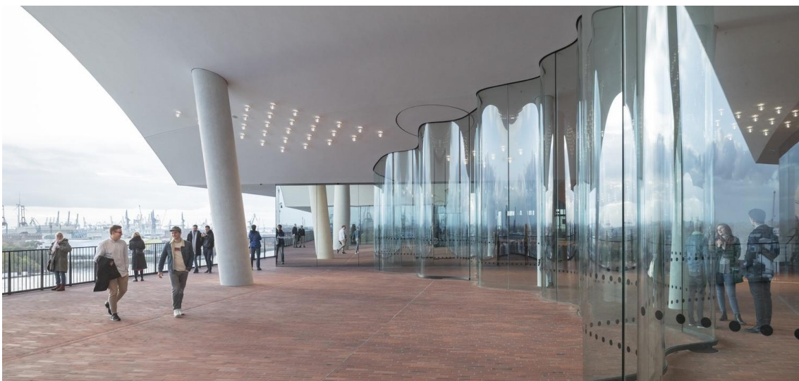
Ilustración 118: Muro cortina da periferia e das entradas do nivel 8 da Elbphilharmonie
