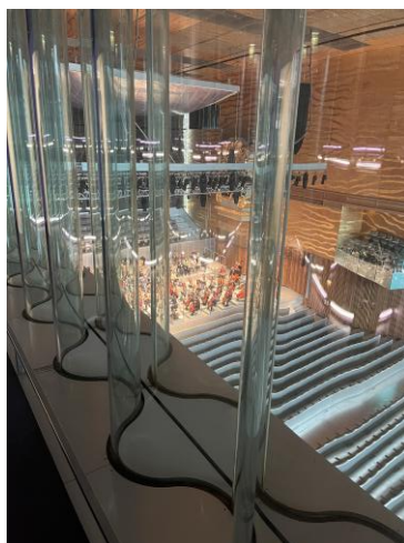
Ilustración 156: Vista cercana dun muro cortina interior duplo da Casa da Música. Autoría propia
