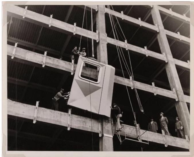
Ilustración 13: Building Colocación dun dos módulos de aluminio da fachada en 1952
