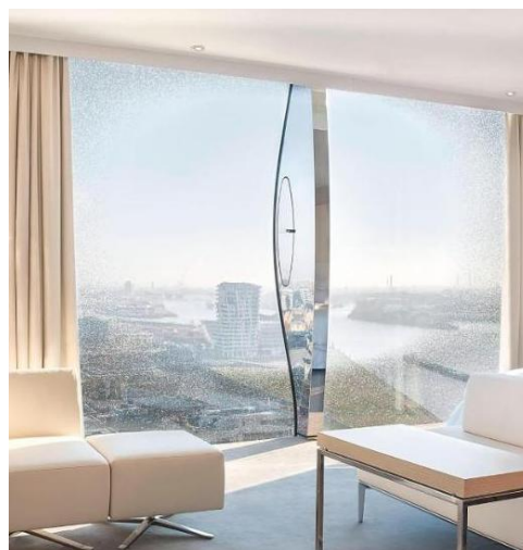
Ilustración 121: Morfoloxía de muro cortina na Elbphilharmonie con ondulación na vertical
