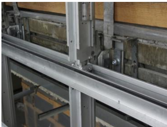
Ilustración 18: Detalle do muro cortina orixinal da Torre Pirelli
