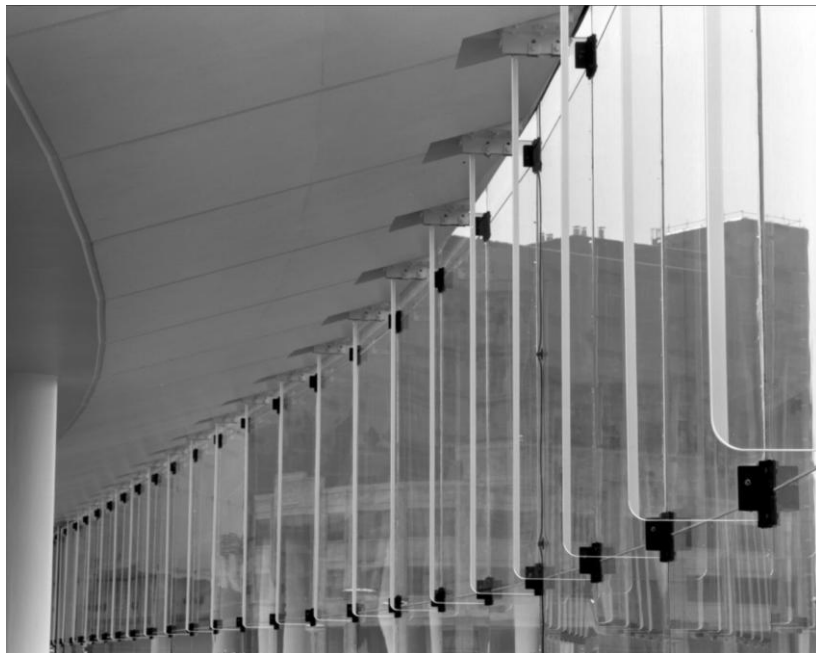
Ilustración 24: Detalle fotográfico do muro cortina Willis Faber and Dumas Headquarters, Ipswich, Inglaterra
