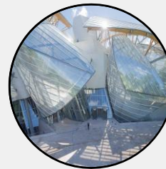
PROTECCIÓN SOLAR: AS "VELAS" DE MURO CORTINA
