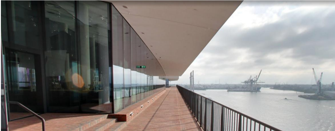
Ilustración 113: Recuamento da planta 8 da Elbphilharmonie para obter protección solar cos niveis superiores
