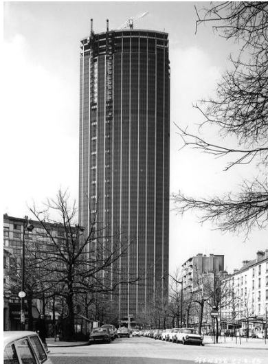
Ilustración 21: Construción da fachada de muro cortina da Tour Montparnasse
