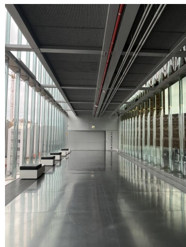
Ilustración 160: Espazo intermedio entre muros cortina da fachada Este da Casa da Música. Autoría propia
