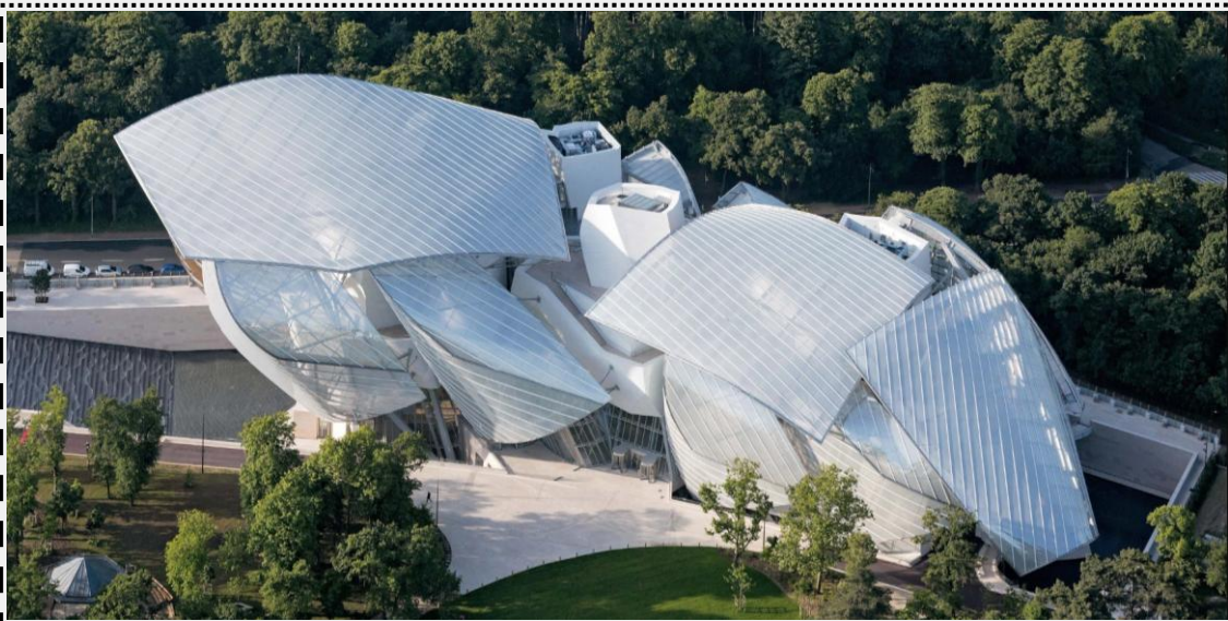
PROTECCIÓN SOLAR: AS "VELAS" DE MURO CORTINA
