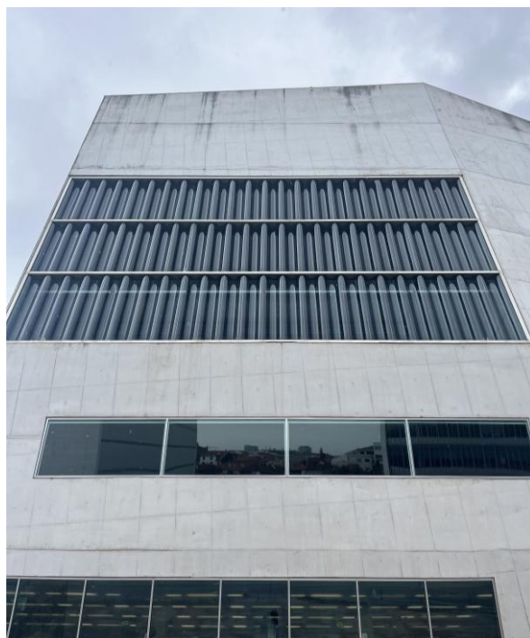
Ilustración 145: Muro cortina estrutural ondulado da fachada Oeste da Casa da Música. Autoría propia
