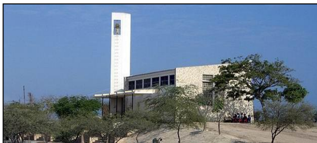
Imagem 1: Capela da Nossa Senhora da Graça vista lateral
