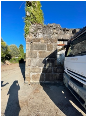
Ilustración 106. Fachada oeste del hotel (2022). Fuente: Sheila Villar Gonzalez.
