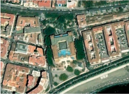
Ilustración 52. Vista aérea del Hotel (2012). Fuente: Google Maps.
