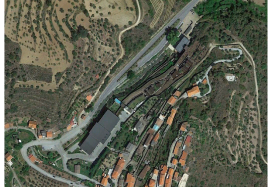
Ilustración 59 Imagen aérea del Hotel de Longroiva posterior a la intervención. Fuente: Google Earth
