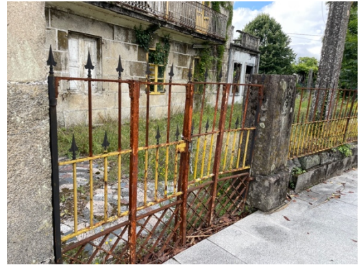
Ilustración 142. Verja hierro muro exterior (2023). Fuente: Sheila Villar Gonzalez.
