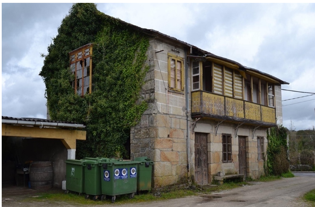
Ilustración 124. Imagen de la vivienda de trabajadores ya abandonada en donde se observan los balcones descritos anteriormente. (2016). Fuente: Entre Ruinas.
