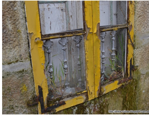
Ilustración 124. Ventana fachada norte hotel (2016). Fuente: Entre Ruinas.
