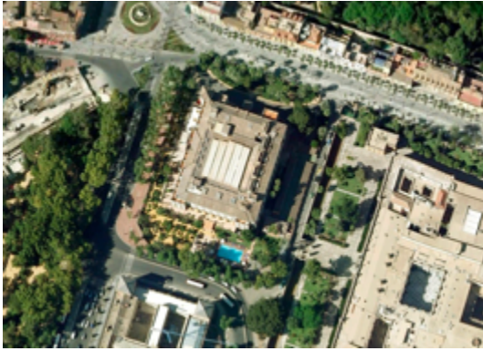
Ilustración 63. Vista aérea del Hotel (2017). Fuente: Google Maps.
