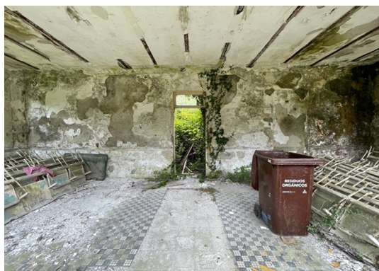
Ilustración 158. Fotografía del estado actual interior de la ampliación, tomada desde la puerta de entrada (2022). Fuente: Sheila Villar Gonzalez.
