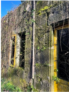
Ilustración 111. Fachada oeste del hotel (2022). Fuente: Sheila Villar Gonzalez.
