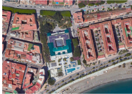
Ilustración 53. Vista aérea del Hotel (2022). Fuente: Google Maps.
