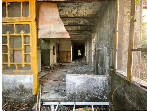
Ilustración 121. Fachada norte de la galería (2022). Fuente: Sheila Villar Gonzalez.
