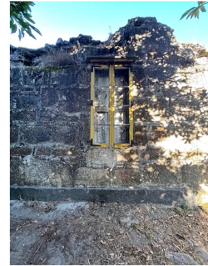
Ilustración 108. Fachada oeste del hotel (2022). Fuente: Sheila Villar Gonzalez.
