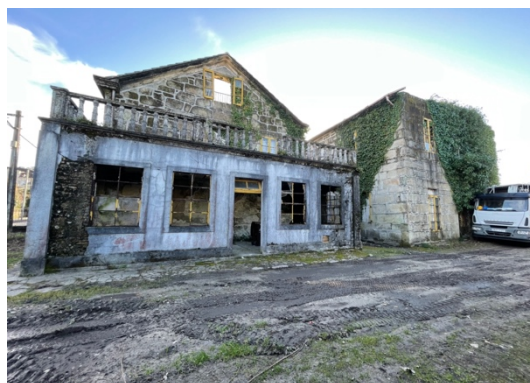
Ilustración 159. Fotografía que muestra el estado actual exterior de la ampliación de la fachada norte (2022). Fuente: Sheila Villar Gonzalez.
