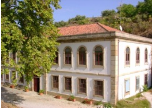
Ilustración 56. Imagen previa a la intervención. Fuente: Longroiva Hotel.
