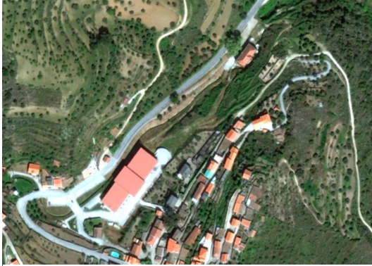
Ilustración 58 Imagen aérea del Hotel de Longroiva previo a la intervención. Fuente: Google Earth
