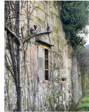
Ilustración 113. Fachada oeste de la vivienda de trabajadores (2022). Fuente: Sheila Villar Gonzalez.
