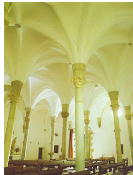
Fig. 38 - Perspectiva interior da Igreja de Mértola
