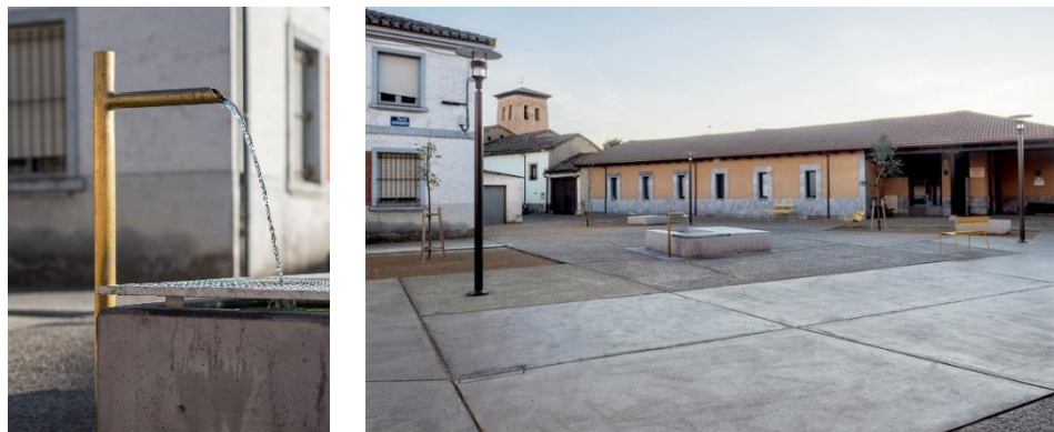
Fig. 306 – Materialidade e técnicas construtivas empregadas.
