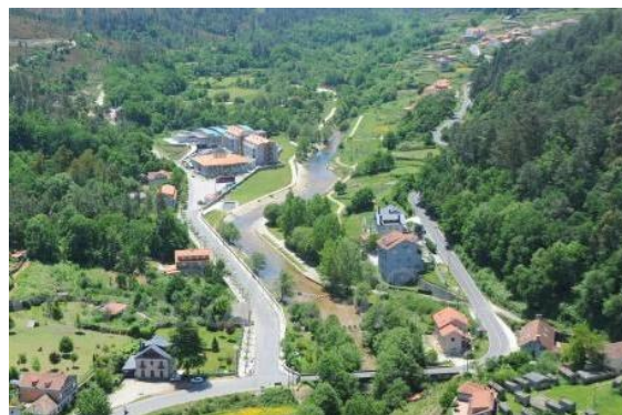
Fig. 147 – Praia fluvial e área termal dos Baños.
