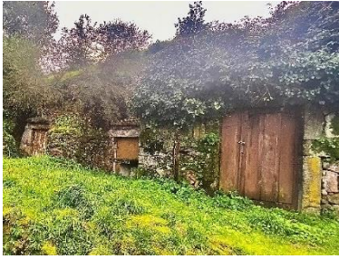
Fig. 102 – Adegas escavadas na montaña.
