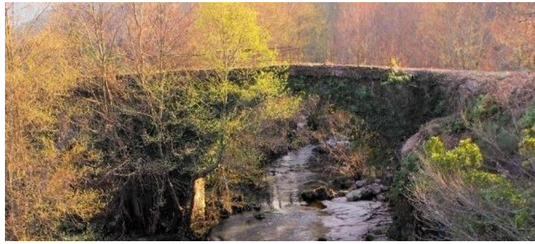
Fig. 141 – Ponte de Carballedo.
