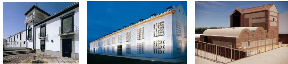
Fig. 281 – Patrimonio arquitectónico que amosa a materialidade e técnicas construtivas tradicionais.
