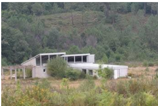
Fig. 215 – Edificio abandonado proxectado como cámping.
