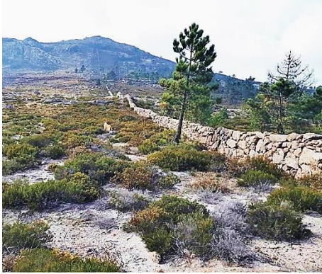
Fig. 92 – Antigo muro fronteirizo.
