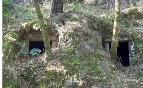
Fig. 117 – Adegas escavadas no terreo.
