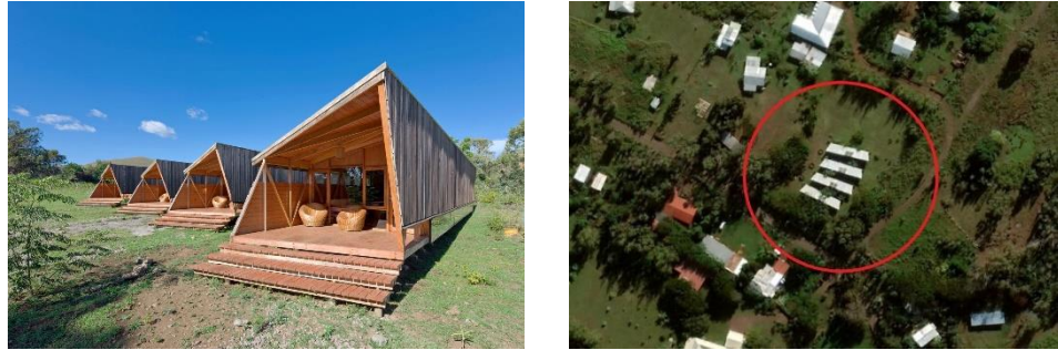
Fig. 320 – Vistas xerais da intervención.
