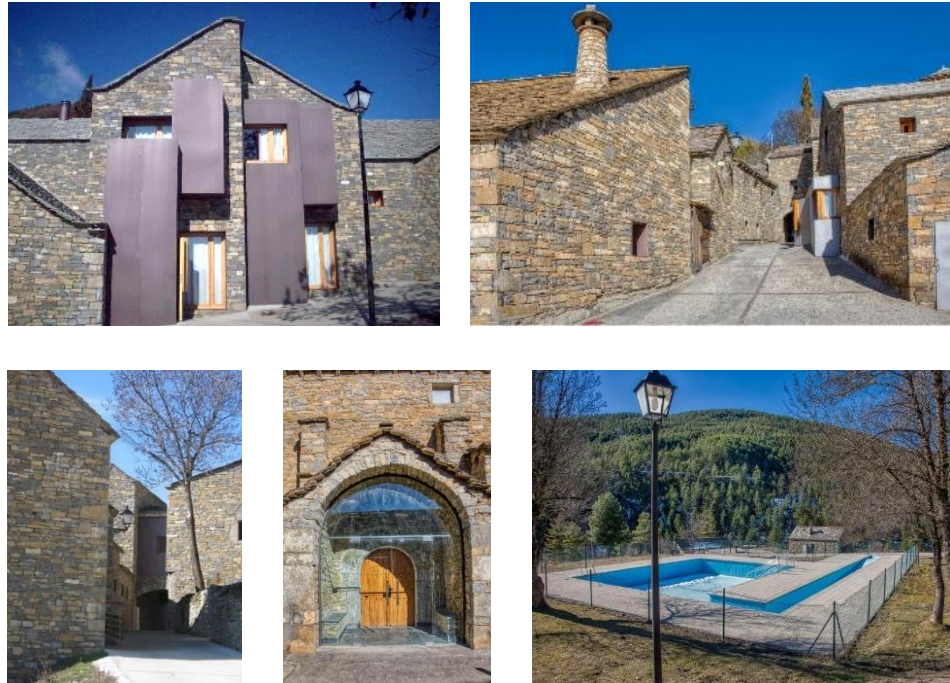
Fig. 296 – Inserción de novos materiais e técnicas para diferenciar a nova intervención.
