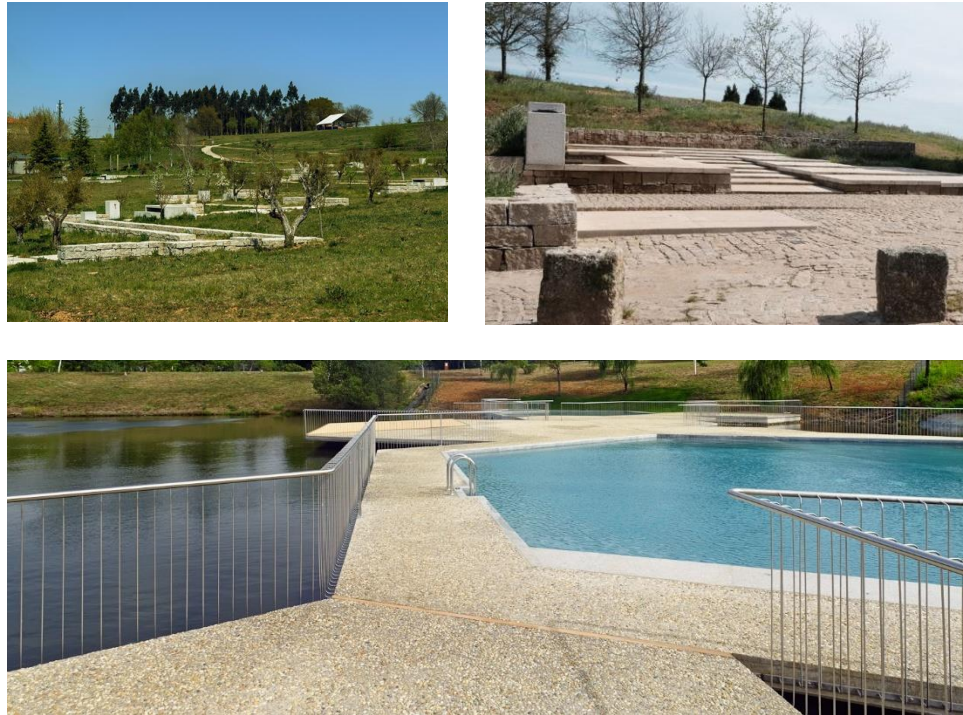
Fig. 239 – Materialidade e técnicas construtivas empregadas.
