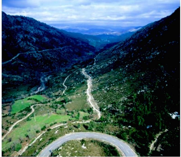
Fig. 86 – Estrada actual, río Caldo, camiño medieval e Vía Nova.
