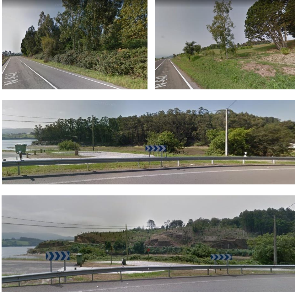
Fig. 257 –Dúas comparativas do antes e despois da intervención.
