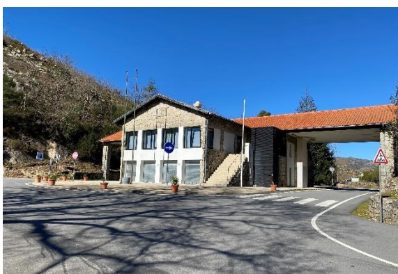
Fig. 188 – Antiga aduana portuguesa reconvertida en establecemento de hostalería.
