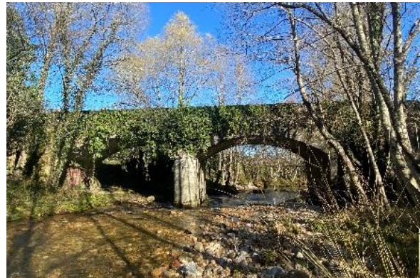
Fig. 139 – Ponte da estrada OU- 312 nos Baños.
