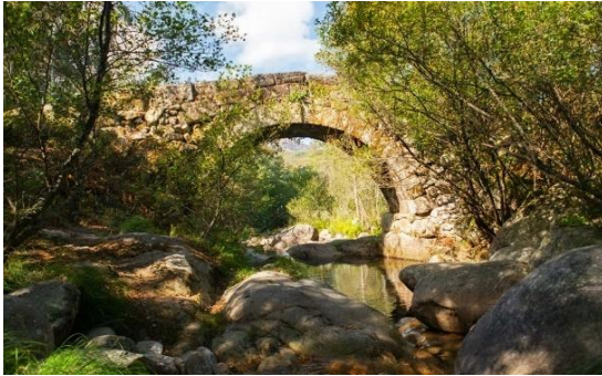
Fig. 162 – Ponte da Pontenova.
