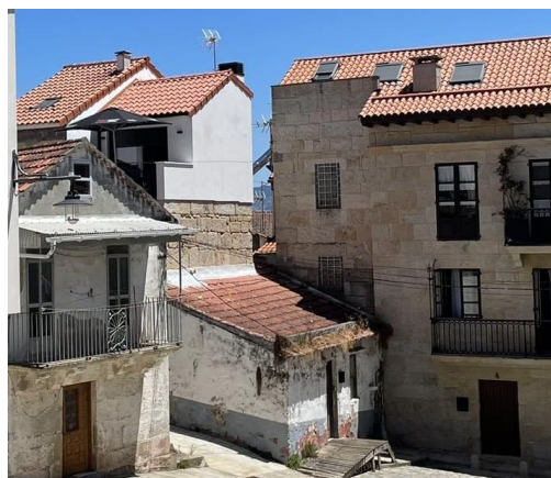
Fig. 94.- Casa térrea expropiada, con nivel de protección integral, Eirado do Costal, 2025. Fuente: Elaboración propia.
