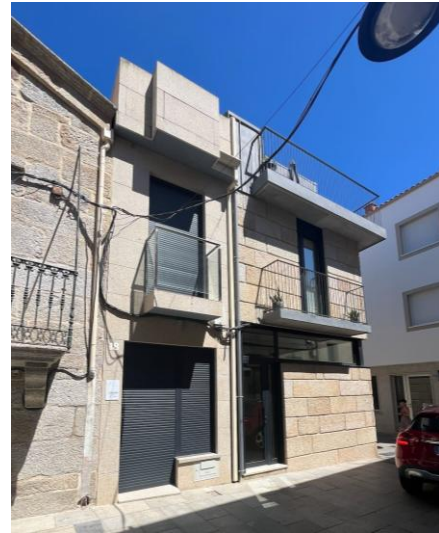
Fig. 102.- Dos Viviendas intervenidas para alquiler turístico, 2025. Fuente: Elaboración propia.
