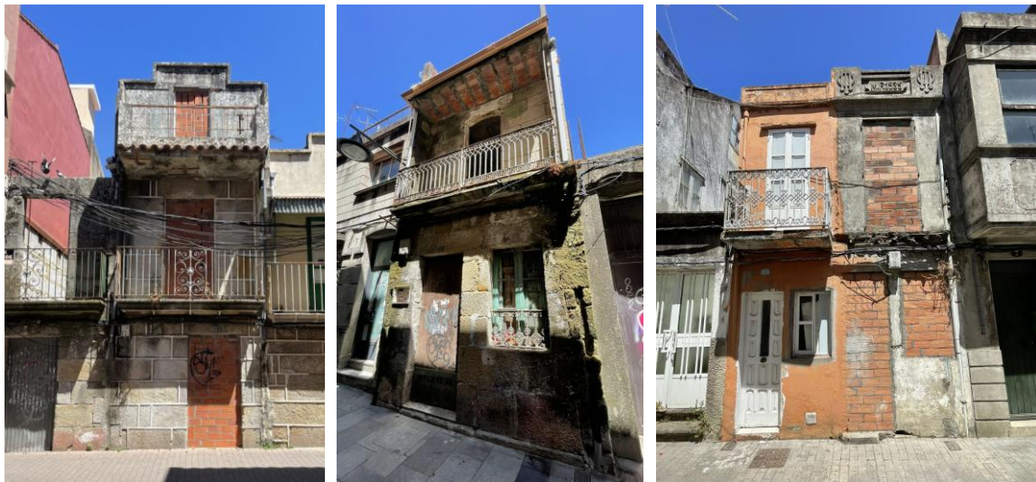
Fig. 54.-Tres de las viviendas en estado de abandono y/o ruina en el casco histórico de Cangas, 2025. Fuente: Elaboración propia.
