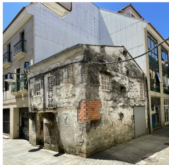
Fig. 80.- Vivienda abandonada con protección estructural, 2025. Fuente: Elaboración propia.
