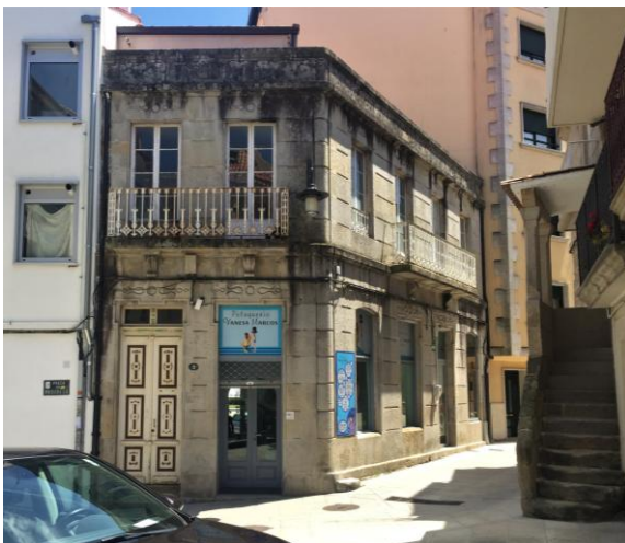
Fig. 81.- Vivienda con protección estructural, y bajo comercial, 2018. Fuente: Elaboración propia.
