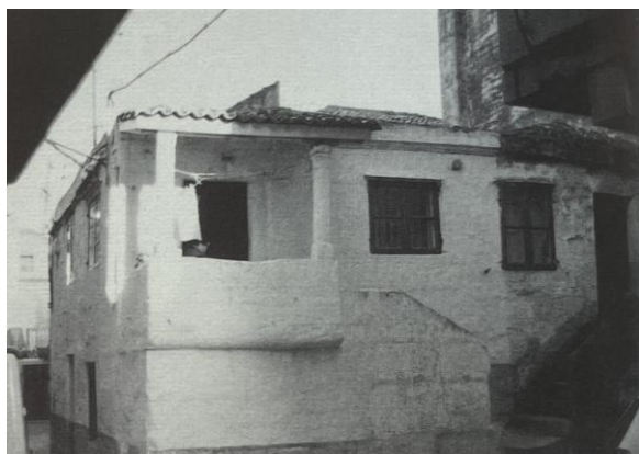
Fig. 57.-Conjunto de viviendas de patín. Fuente: Mallo Lagoa, p. (1991, p. 72)
