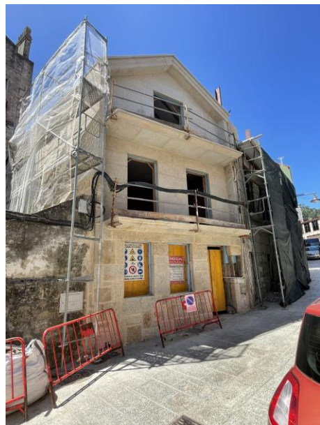
Fig. 60.-Intervención sobre vivienda (fig. 32) (En el cartel de obra figura que se trata de una estructuración y ampliación de vivienda), 2025. Fuente: Elaboración propia.
