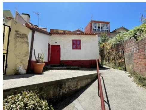
Fig. 85.- Casa térrea con protec. integral, 2025. Fuente: Elaboración propia.
