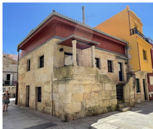
Fig. 58.- Conjunto de viviendas de patín con protección integral intervenidas en 2005, 2025. Fuente: Elaboración propia.
