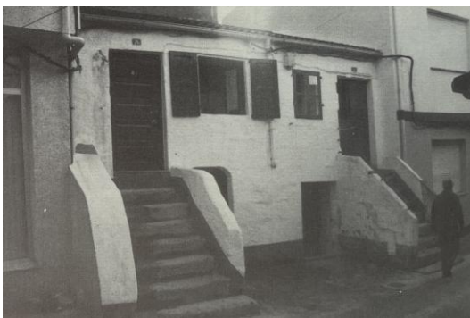
Fig. 72.-Casas patín paralelo a la fachada, 1991. Fuente: Mallo Lagoa, p. (1991, p. 72)
