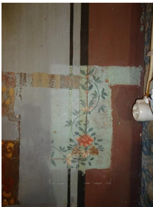
Figura 18 - Janelas de sondagem para observação das campanhas decorativas subjacentes (E.O.P.P.,SA., 2011)
