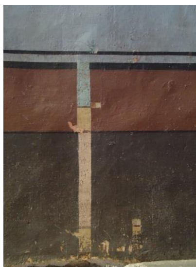
Figura 8 -Sondagem de observação do lambril da decoração Neoclássica. (E.O.P.P.,SA., 2011)
