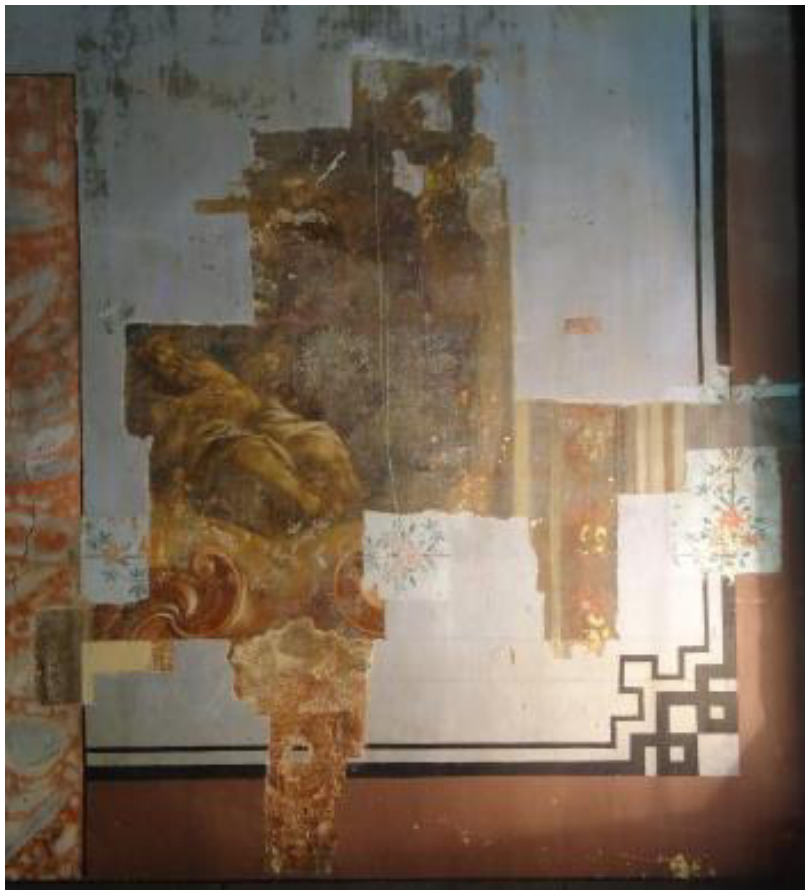
Figura 23- A principal janela de sondagem (E.O.P.P.,SA., 2011)
