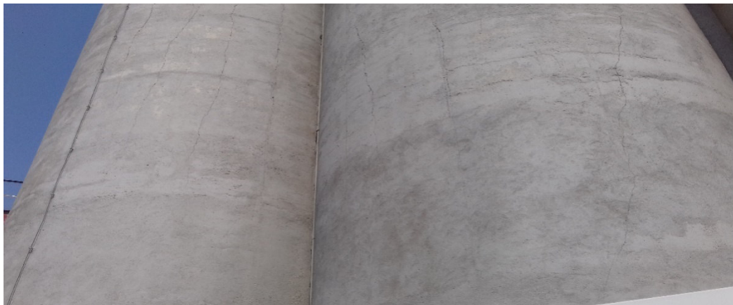
FIGURA 1: Fotos de Silos do Porto do Lobito em mau estado de conservação
