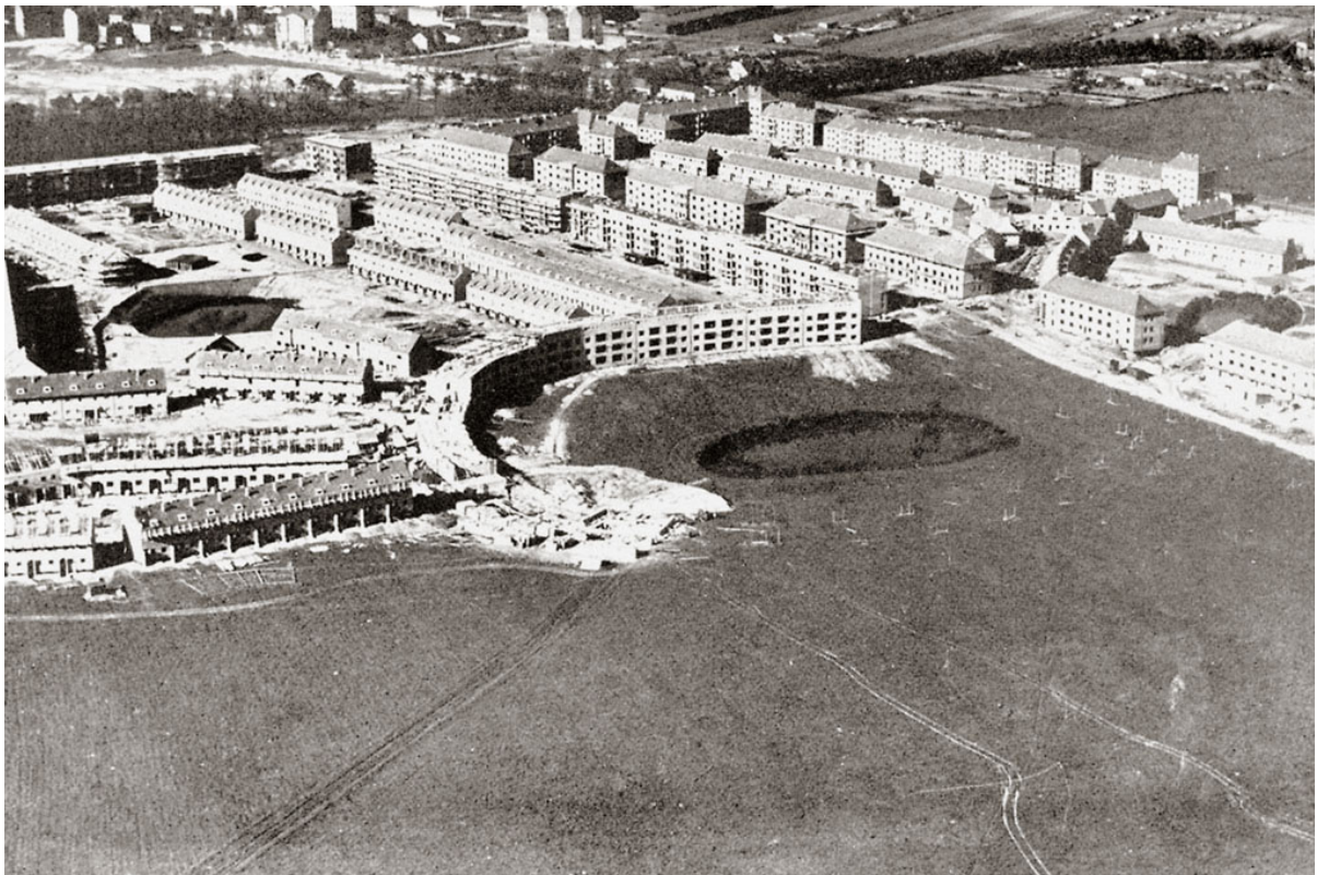
Figura 83: Herradura en construcción
