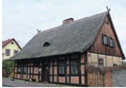
Lehmbaukurse house with clay plaster, Biesenthal bei Bernau, Brandenburg. (photo: René Guérin)
