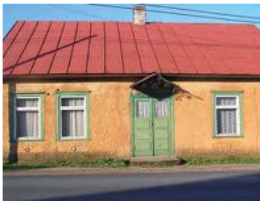
House in rammed earth in Põlva, Põlvamaa. (photo: Marko Kikas, Saviikumaja)
