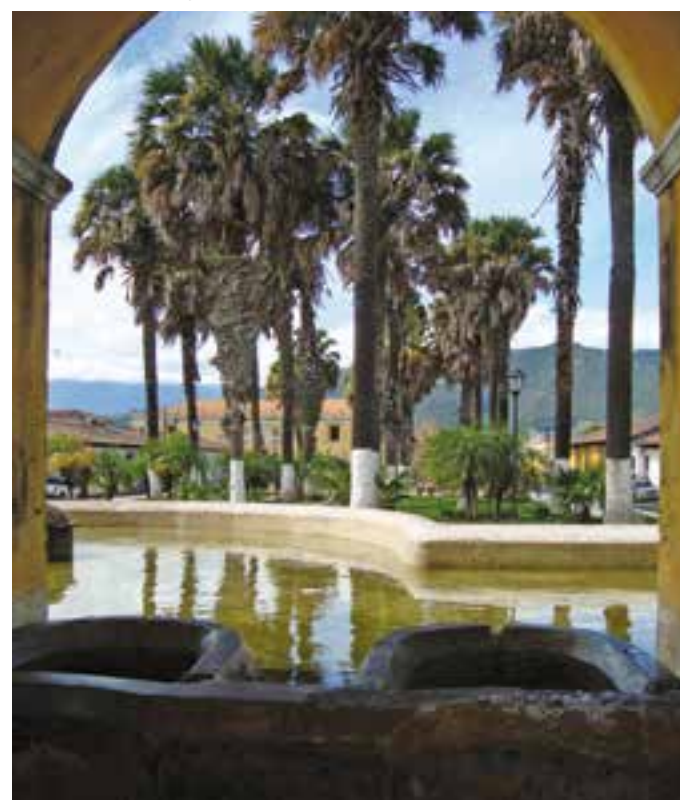
Fig. 1 Washhouse, Antigua Guatemala (photo: G. D. Carlos).
