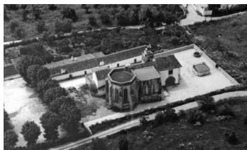
Figura 8: Vista general de las Casas dos Romeiros, Alcácer do Sal, Portugal.
