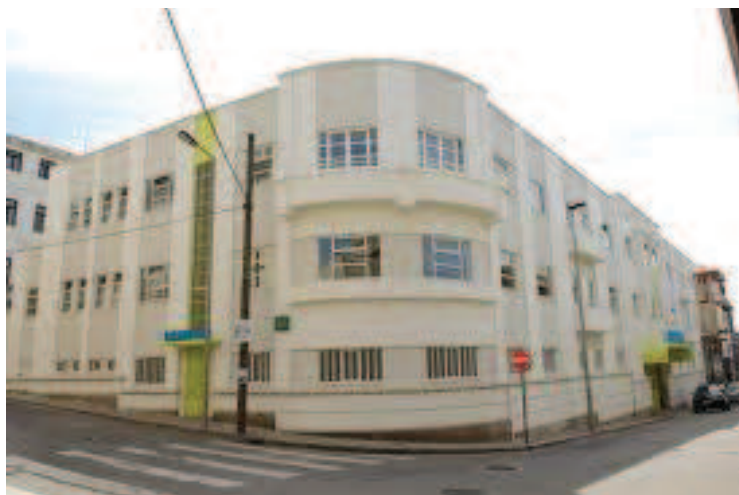
Figura n.º 3 – Fachada das instalações do ER na Rua do Bonjardim
