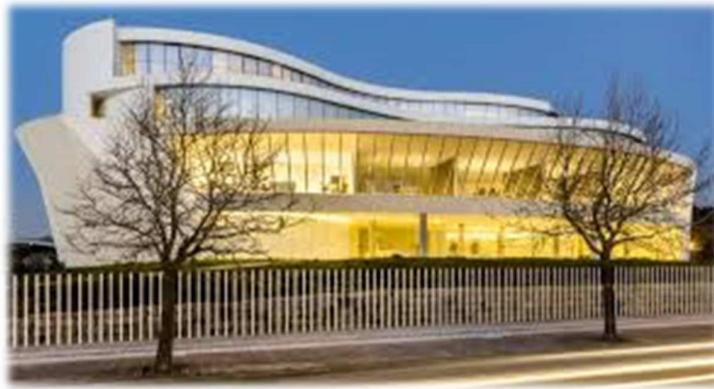
Figura 10 Instalações do CEiiA em Matosinhos
