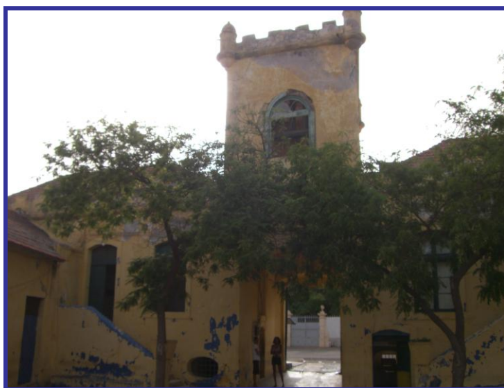
Figura 24 - A entrada do quartel vista do pátio interna
