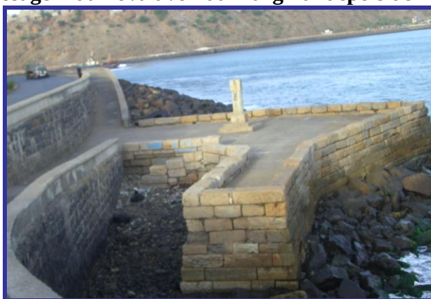
Figura 3 - Memória do cais de S. Januário depois de removido por causa da passagem da nova avenida marginal depois de 2001
