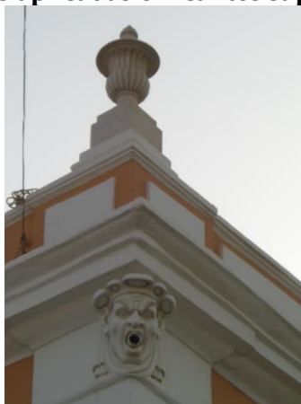
Figura 10 - Uma das gárgulas aplicadas em cantos superiores do edifício
