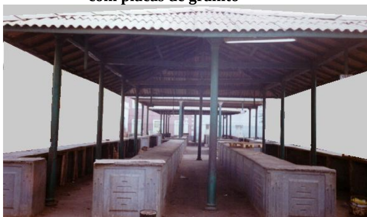
Figura 28 - Interior do Mercado Municipal revelando balcões de cimento cobertos com placas de granito
