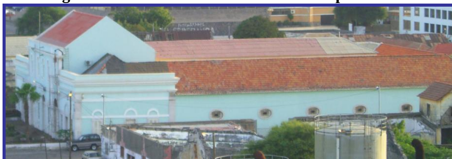
Figura 14 - Vista do edifício depois de restaurado mostrando como se estende em alongamento no eixo do solo e existência de pátio interior
