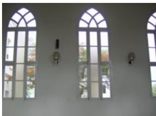
Figura 33 - Janelões simples e belos observados do interior exibindo do edifício
