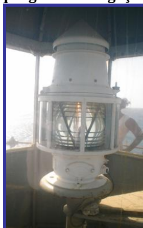
Figura 22 - Estrutura em ferro e vidro de protecção do candeeiro emissor de luz que guia a navegação
