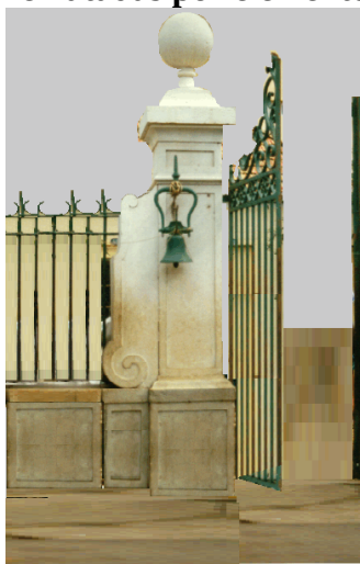
Figura 27 - Um aspecto das ombreiras das portas feitas em forma de colunas revestidas com mármore, rematadas por elementos de forma esférica
