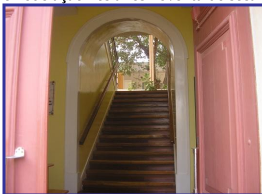
Figura 12 - Escudaria de acesso ao andar nobre restaurada quando a obra recebeu a última remodelação nos anos noventa do século passado.
