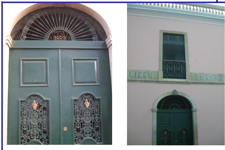
Figura 16 - Pormenores relativos à frente de um dos edifício voltada para o beco
