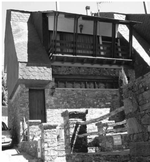
Edifici nou a Nevà (Toses, Ripollès)
