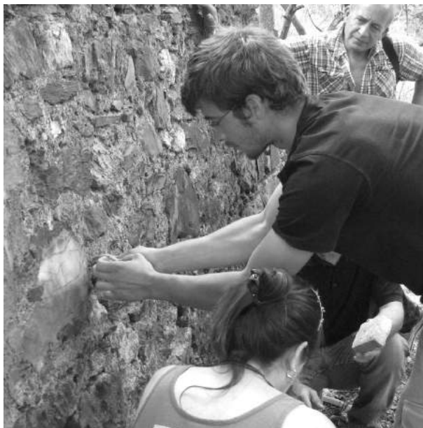
Taller de neteja de mur de pedra
