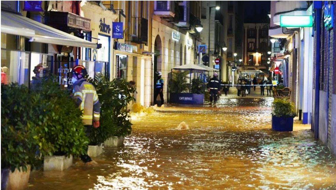
Ilustración 38: Rotura de tubería de abastecimiento en C/ Montero Calvo el 8 de marzo de 2021 (Fuente: La Razón)
