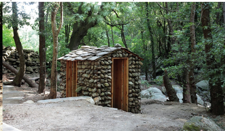
Imagen 3. Pequeña instalación con iluminación autónoma.
