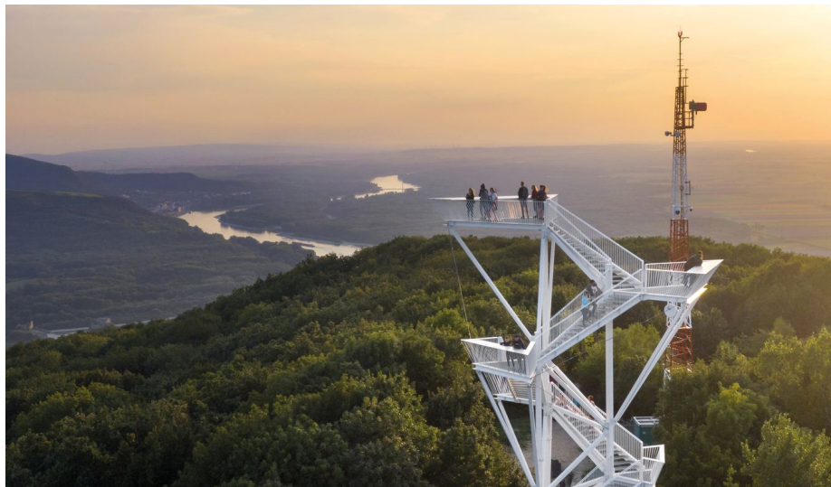
Imagen 1. Contraste entre la torre de observación y la antena de telecomunicaciones.
