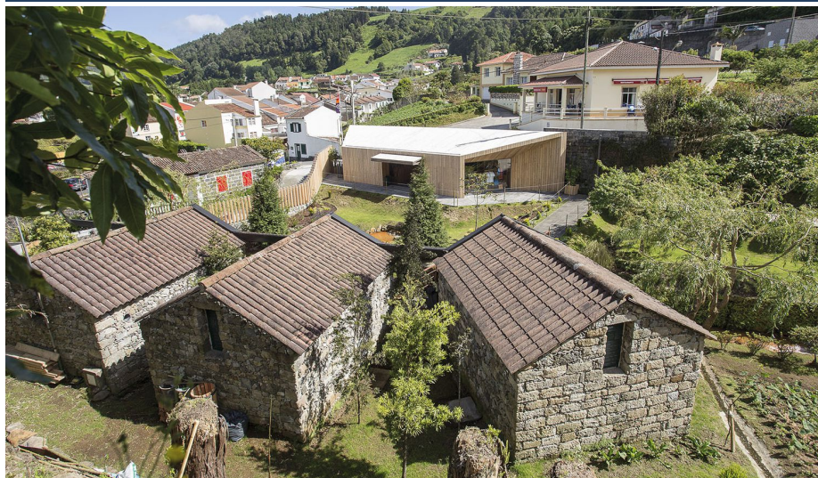
Imagen 1. Unión del aspecto patrimonial con la intervención en madera.
