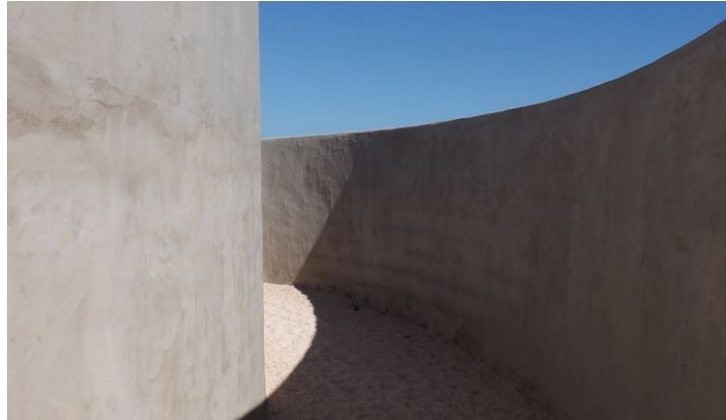
Imagen 2. Interior del recinto laberíntico.
