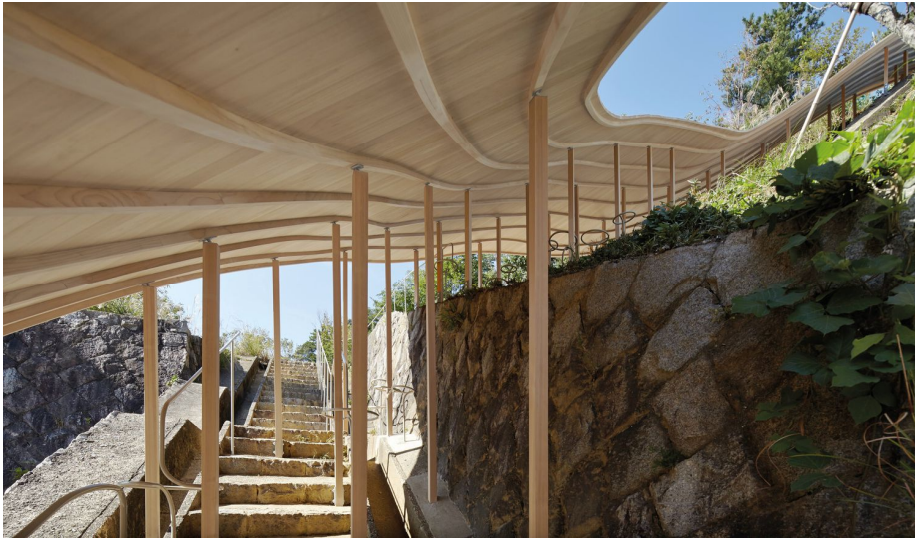
Imagen 1. Interior del pasadizo cubierto.
