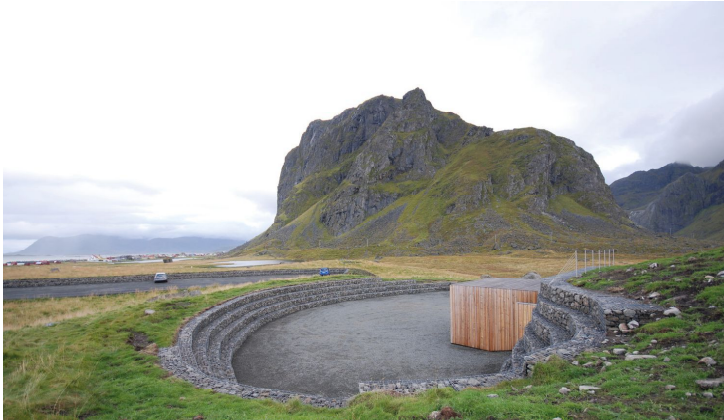
Imagen 2. Detalle del espacio circular delimitado por jaulas de gaviones.
