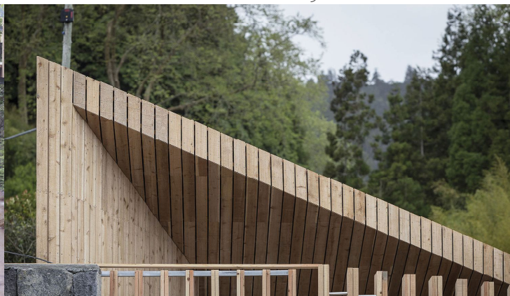
Imagen 3. Detalle del acabado de cerramiento con la madera.
