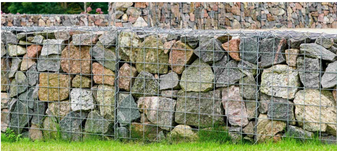
Figura 58 Aspecto de la jaula de gaviones.
