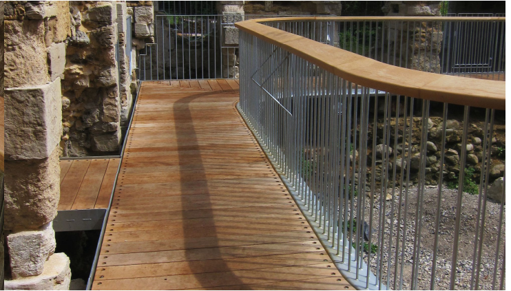
Imagen 3. Detalle del pavimento de la pasarela y barandilla.
