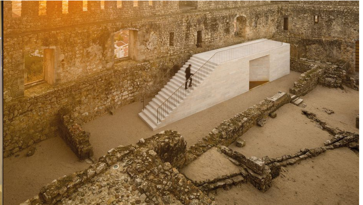
Imagen 3. Aspecto de la cubierta del centro de visitantes.
