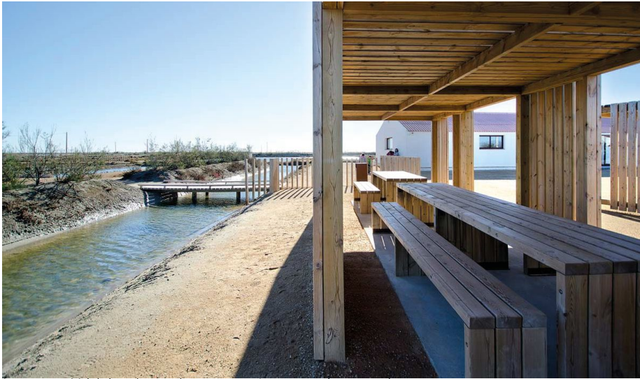
Imagen 1. Módulos de sombra y estancia y pasarela en madera.
