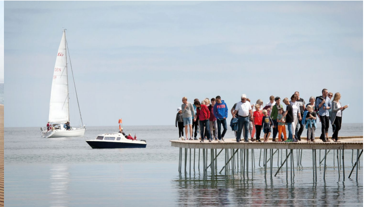
Imagen 3. Detalle de los apoyos y utilización del elemento de contemplación.
