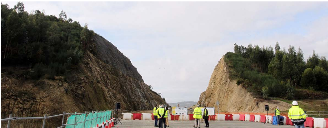
Figura 84 Obras de la futura Autovía de las Rías Baixas A-57 a su paso por Vilaboia.
