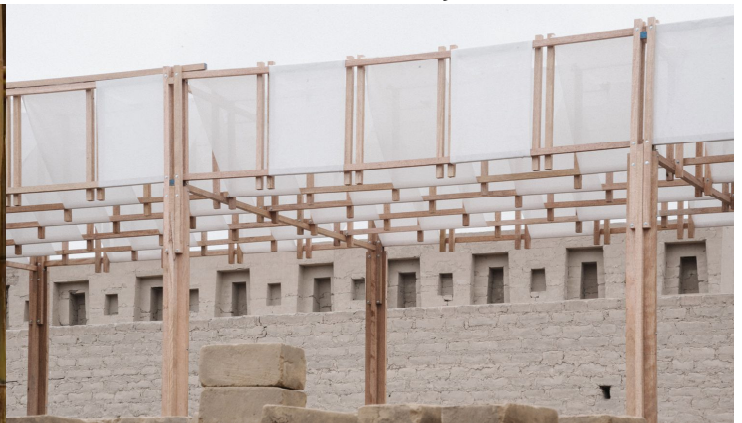
Imagen 3. Integración de los elementos de cubierta con la ruina.
