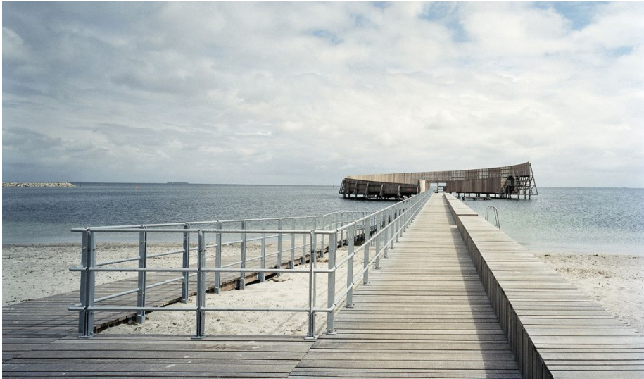
Imagen 1. Aspecto general de la intervención. Acceso principal.
