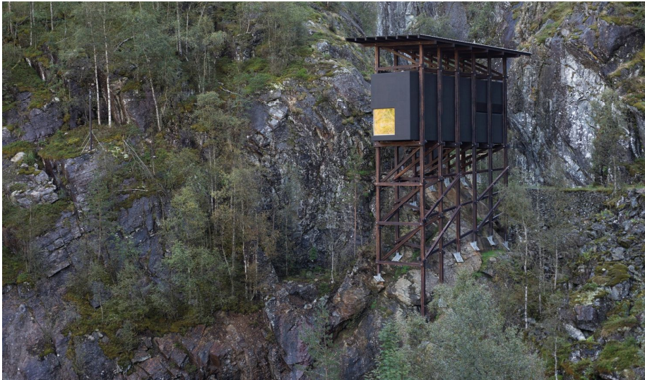
Imagen 1. Aspecto del apoyo del pabellón museo sobre la roca.
