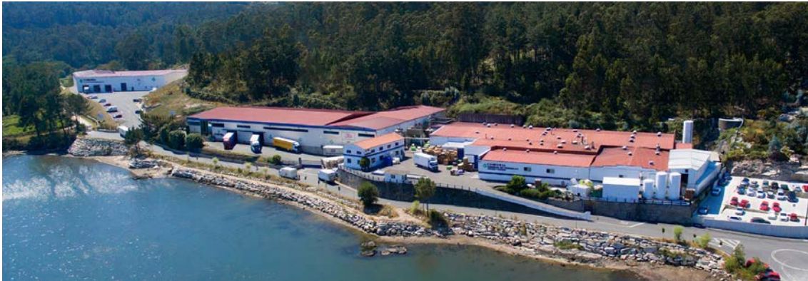
Figura 83 Fábrica conservera Connorsa. Se ubica al sur del ámbito de Ulló.
