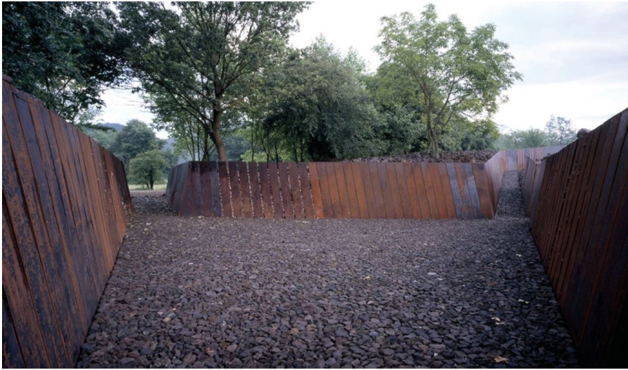
Imagen 1. Espacio angular formado con la contención en acero cortén.
