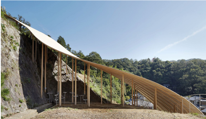
Imagen 2. Alzado de la estructura desde un lateral.
