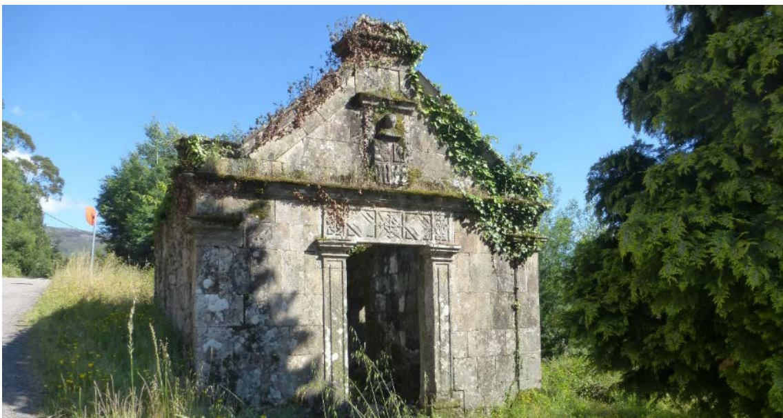
Figura 30 Capilla de Santa Ana, Valença do Minho, Portugal. Un caso de ruina abandonada.
