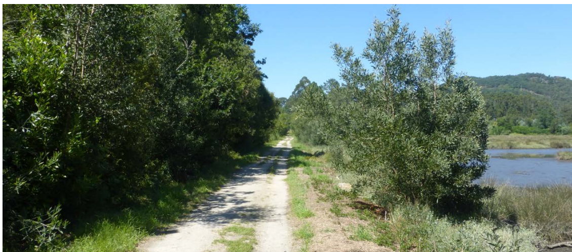
Figura 110 Aspecto del dique de tepe.
