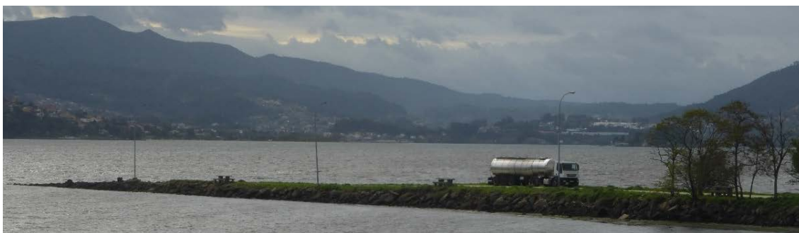
Figura 90 Aspecto del dique de abrigo de Connorsa, ubicado al sur del ámbito de actuación una vez se sale del recinto de Ulló.
