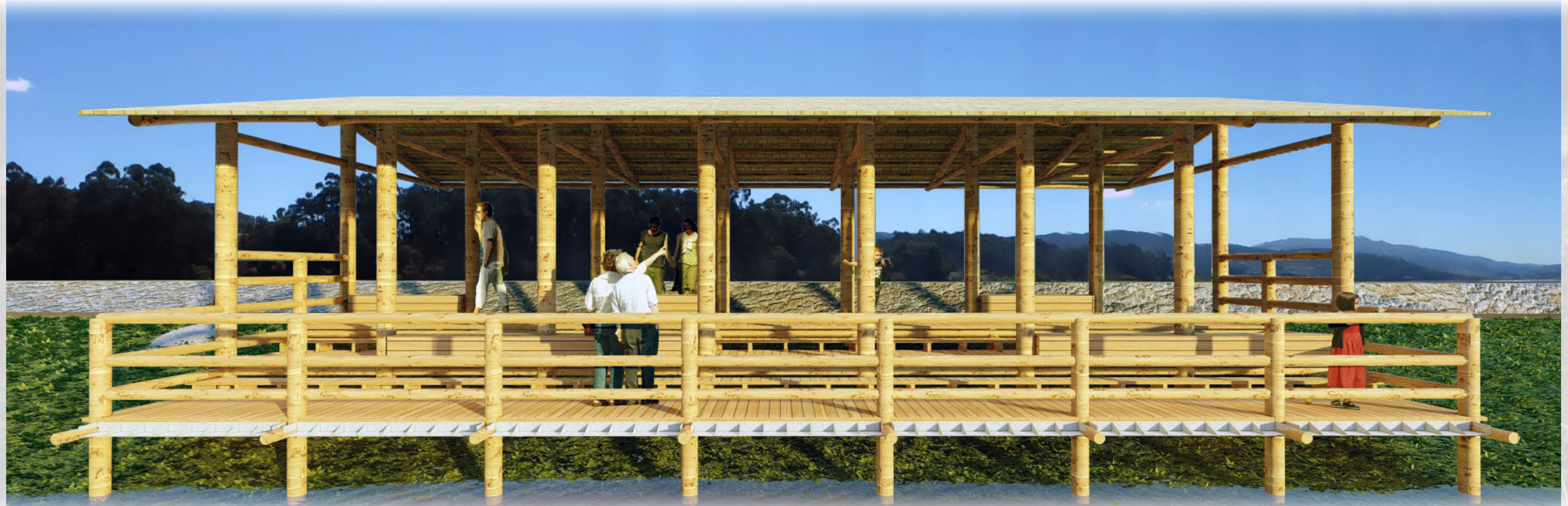
Fig. 7. Pabellón de sal. Imagen de la intervención desde la marisma de Ulló. Se puede apreciar la bandeja de acero INOX para decantar la sal y los distintos niveles con sus bancos.
