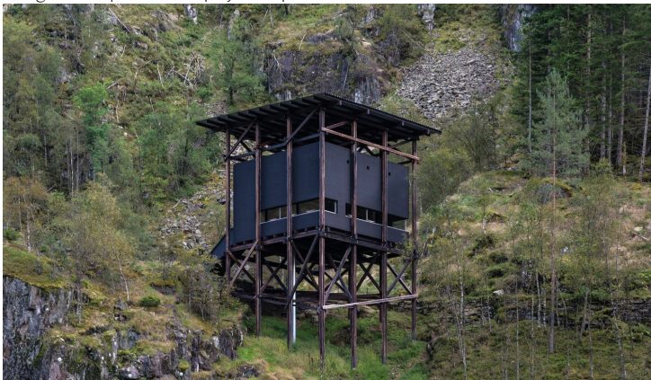
Imagen 2. Módulo de servicio. Detalle del apoyo en terreno.
