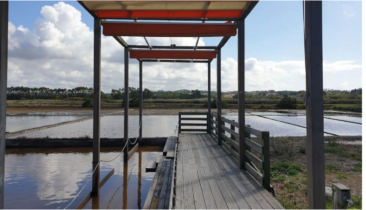
Imagen 3. Instalación pedarium y elementos de sombra.
