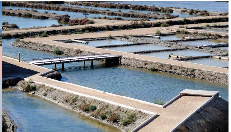
Imagen 3. Pasarela y paseo con elementos de asiento y contención.
