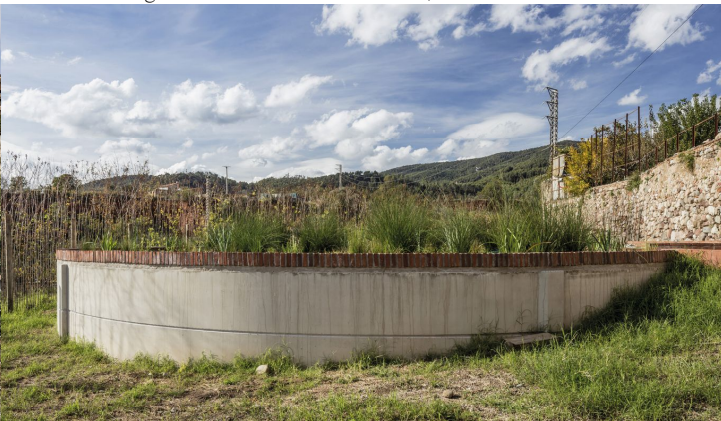
Imagen 3. Detalle del depósito de agua y vegetación.
