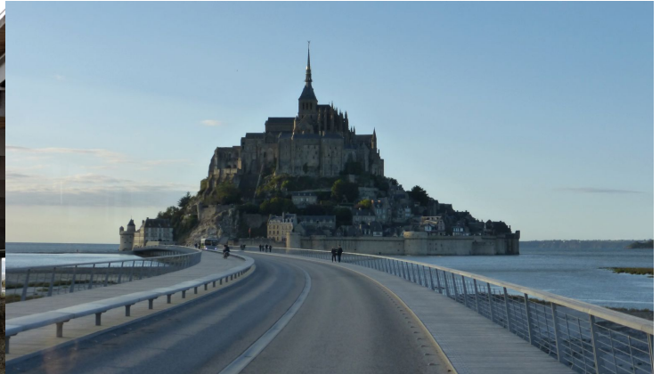
Imagen 3. Vista frontal de la pasarela-muelle.
