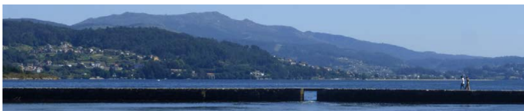
Figura 109 Dique sur con la marea alta. Imagen tomada desde el dique oeste.
