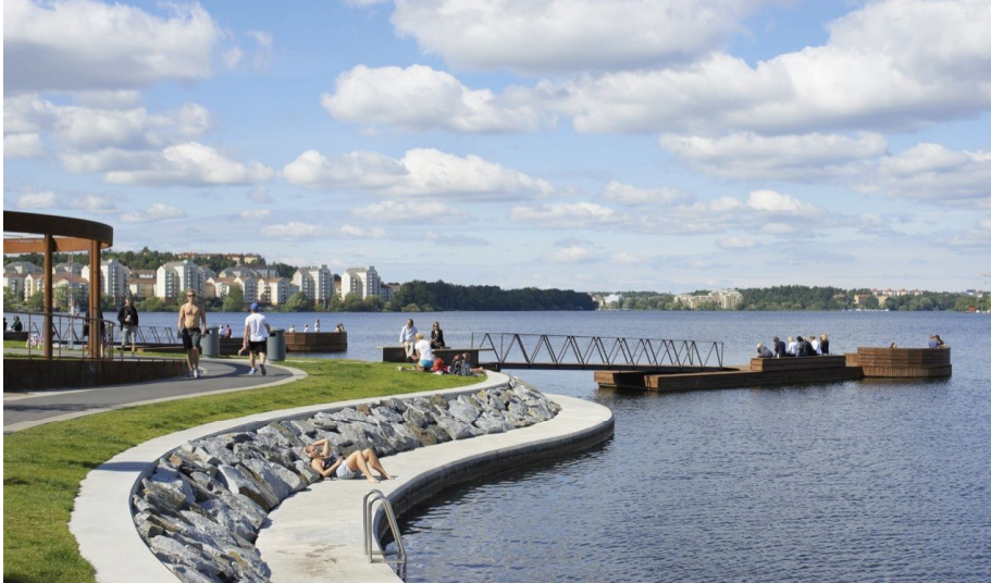
Imagen 1. Aspecto general de la intervención. Módulo flotante y acceso al agua.
