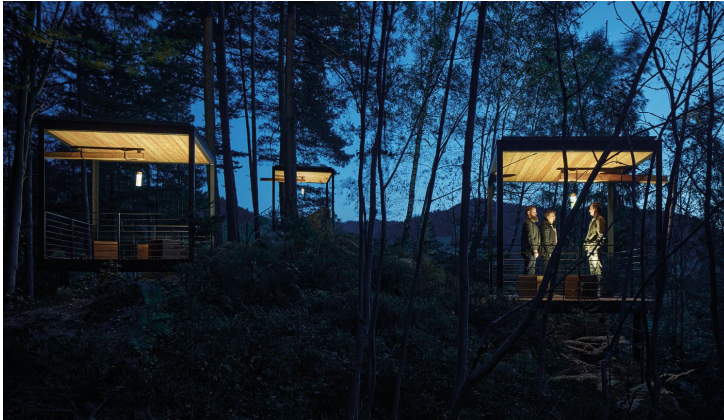
Imagen 2. Iluminación nocturna del conjunto de los elementos caseta.
