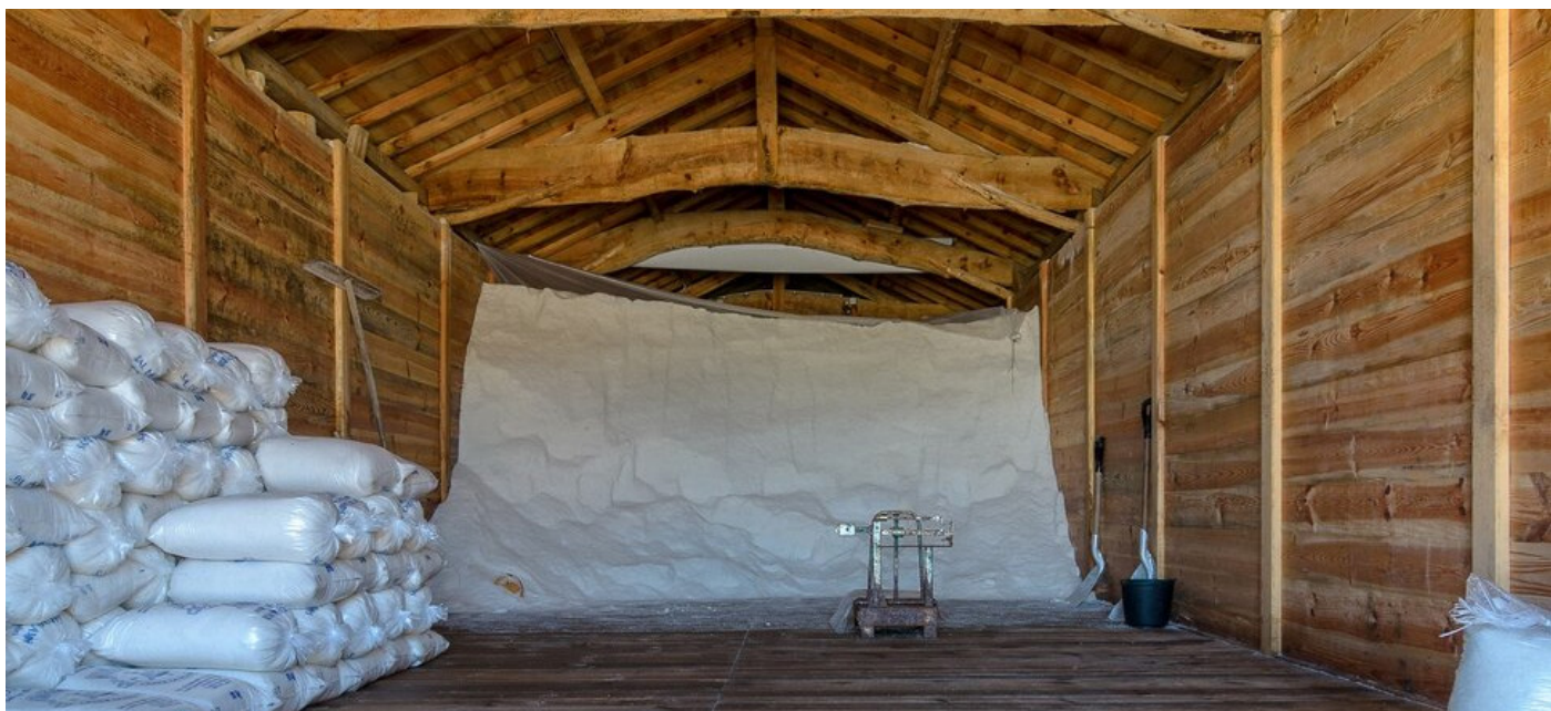
Fig.4: perspectiva interior del alfolí de sal. Esta construcción sigue un sistema constructivo tradicional, con paredes de madera y una estructura porticada con cercas para sostener la cubierta a dos aguas.
