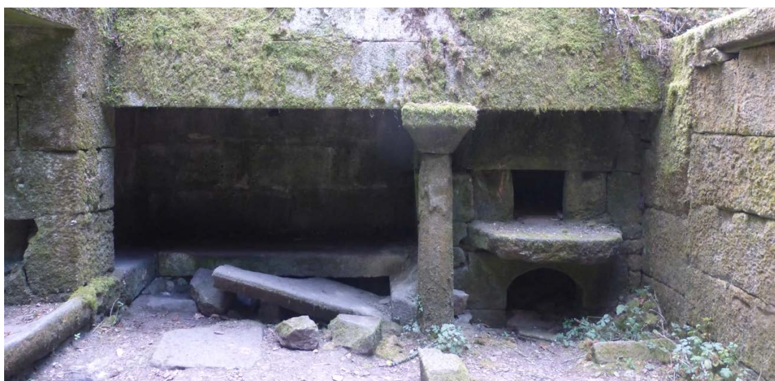
Figura 25 Alzado frontal de una de las chimeneas de Ulló.
