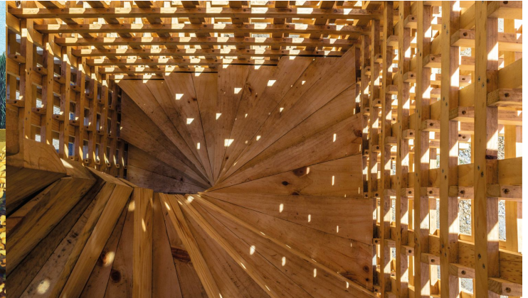
Imagen 3. Detalle de las escaleras de acceso a las torres de contemplación.
