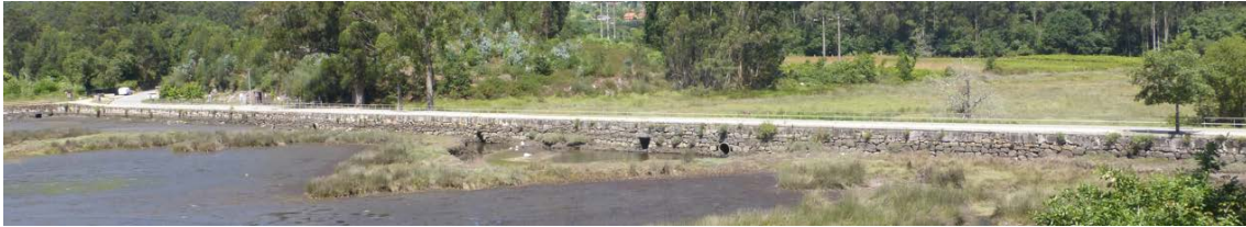
Figura 107 Dique norte desde el paseo al este de la laguna.
