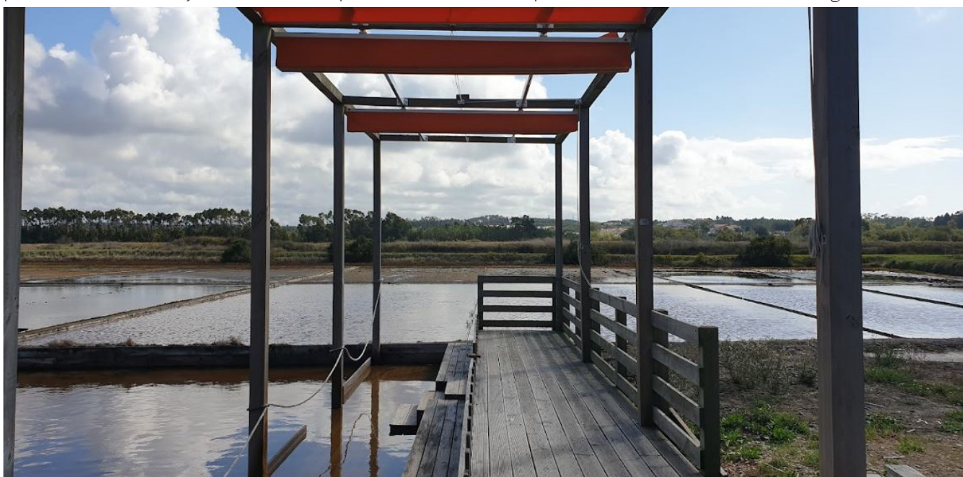
Fig.5: Aspecto en perspectiva de la instalación de pedarium. Se trata de un recinto con un acceso al agua en madera, bajo una cubierta para el sol sostenida por pilares de madera.
