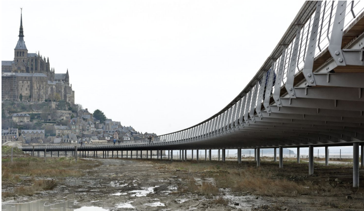
Imagen 2. Aspecto inferior porticado de la pasarela.
