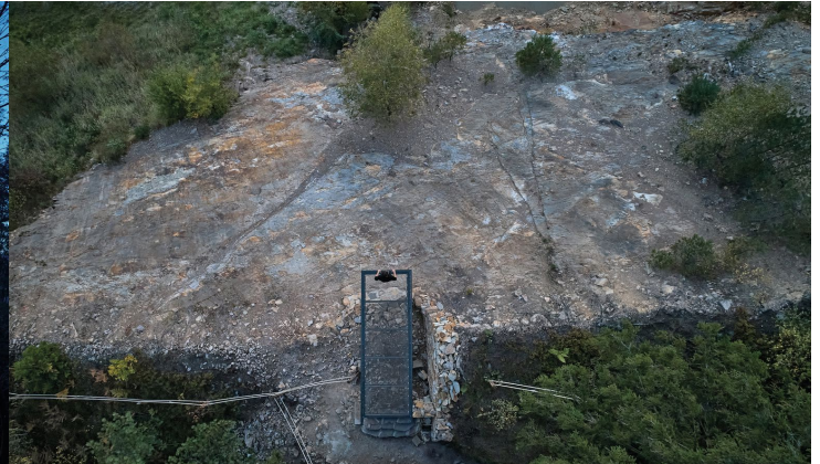
Imagen 3. Aspecto del elemento en voladizo de contemplación del paisaje.
