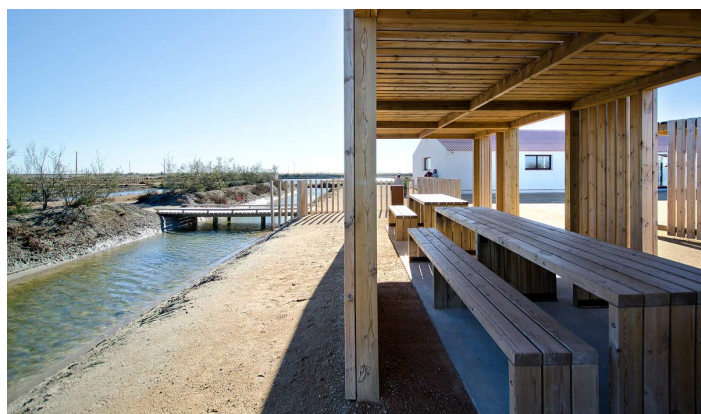
Fig.3: Detalle de las casetas de madera. Es un sistema porticado con una cubierta de lamina de madera para proporcionar sombra y esparcimiento. Los asientos y mesas están posicionados sobre lo que semeja una losa de hormigón pulido.
