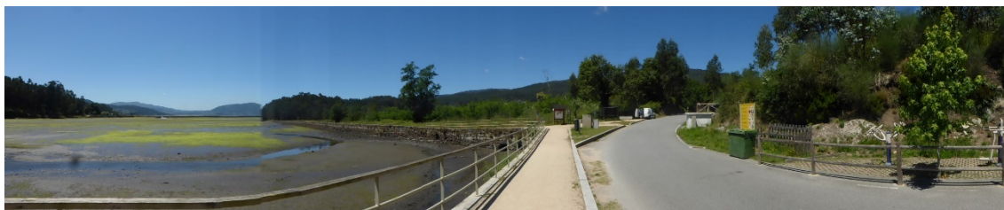
Figura 8 Vial de acceso O Toural – Paredes a su paso por la laguna de Ulló.
