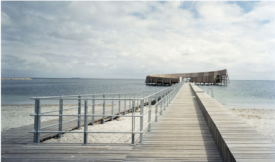
Imagen 1. Aspecto general de la intervención. Acceso principal.
