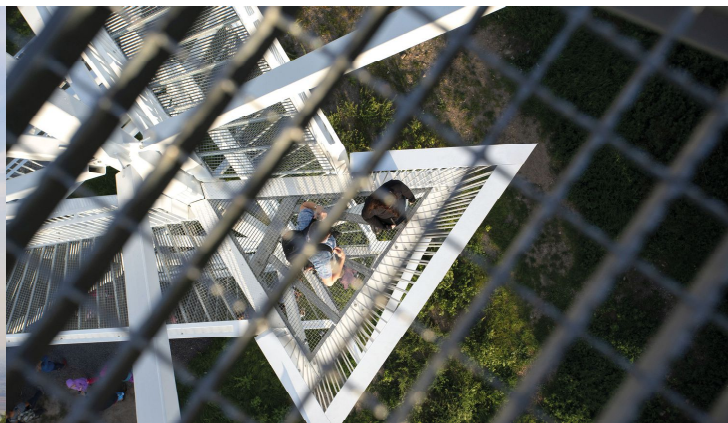
Imagen 3. Detalle de la formación del suelo mediante malla de acero.
