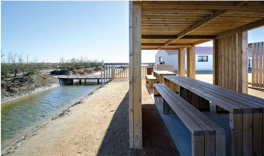
Imagen 1. Módulos de sombra y estancia y pasarela en madera.
