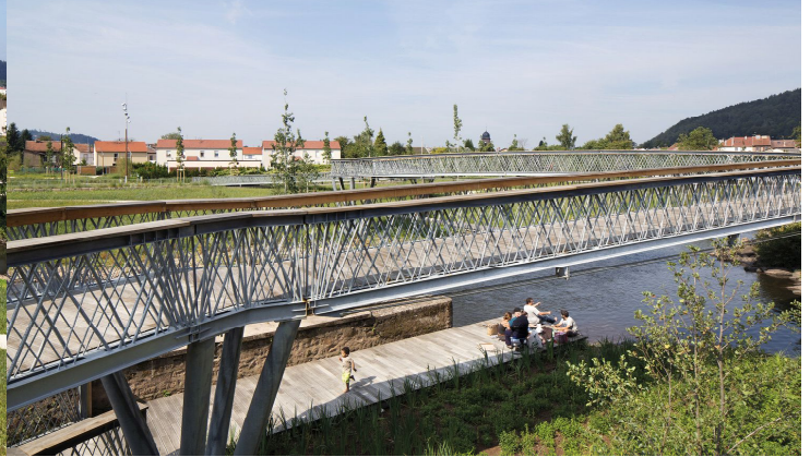
Imagen 3. Detalle de la barandilla de la pasarela, apoyo y acceso al río.
