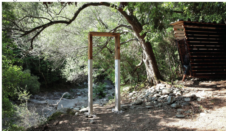
Imagen 2. Pórtico escultórico y pabellón.
