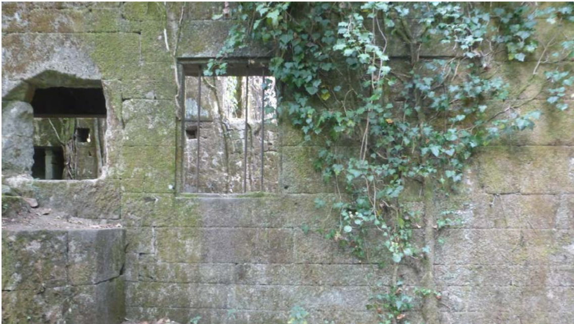
Figura 128 Vano tapiado con fábrica de ladrillo.
