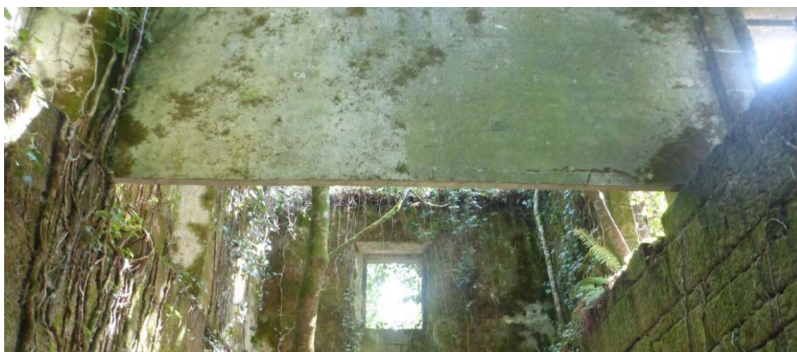
Figura 127 Elemento en fábrica de ladrillo sin apoyo estructural.
