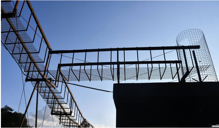
Imagen 2. Pasarela y voladizo mirador sobre la cubierta del edificio.
