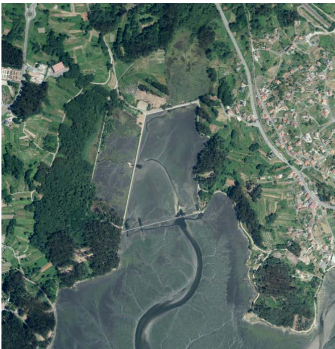
Figura 17 Imagen aérea del año 2020 de la zona de intervención.
