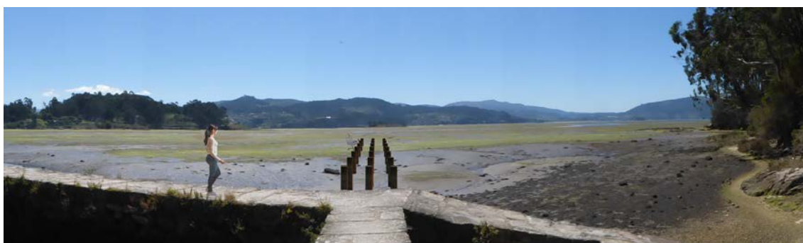
Figura 44 Aspecto del muelle de embarque de sal.
