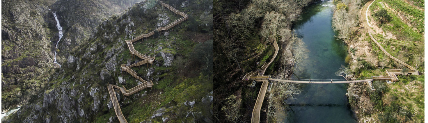
Imagen 2. Alzado lateral de las pasarelas.
