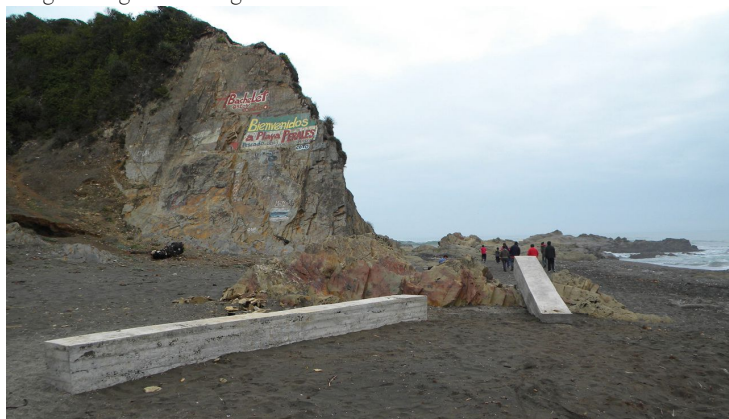
Imagen 2. Detalle de las vigas de hormigón armado dispuestas en la roca.
