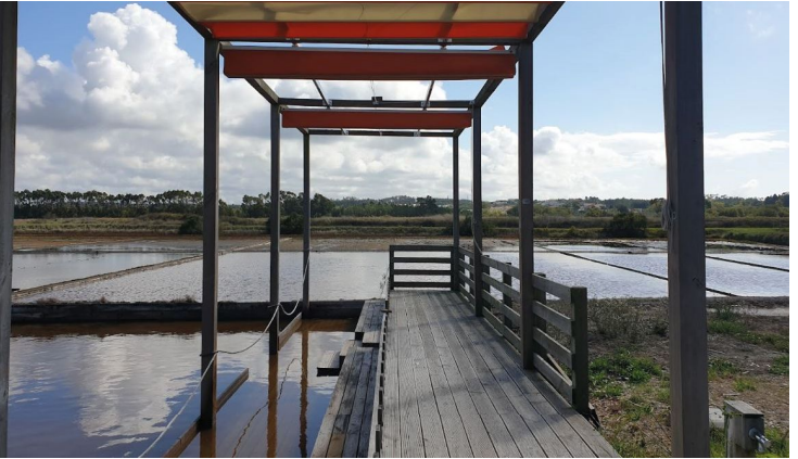
Imagen 3. Instalación pedarium y elementos de sombra.
