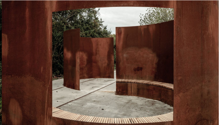
Imagen 3. Espacio de parada con bancos y elementos de acero cortén.
