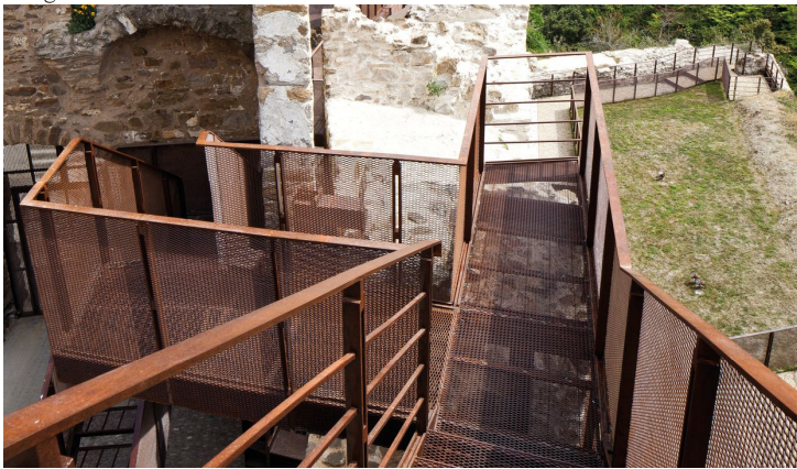
Imagen 2. Detalle del acceso con estructura metálica.
