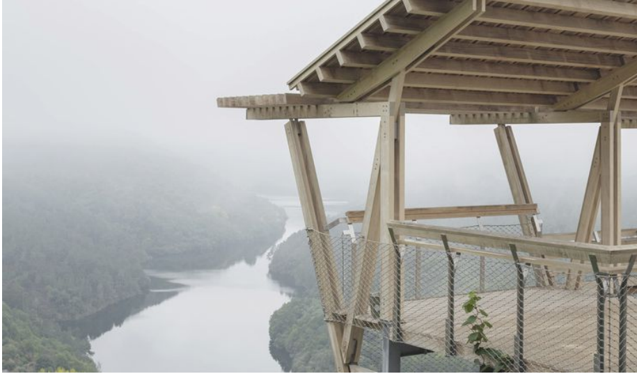
Imagen 1. Aspecto del mirador en voladizo, elevado sobre el paisaje agrícola.
