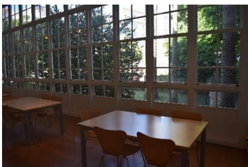
Figura 142. Vista de la galería de fachada posterior.
