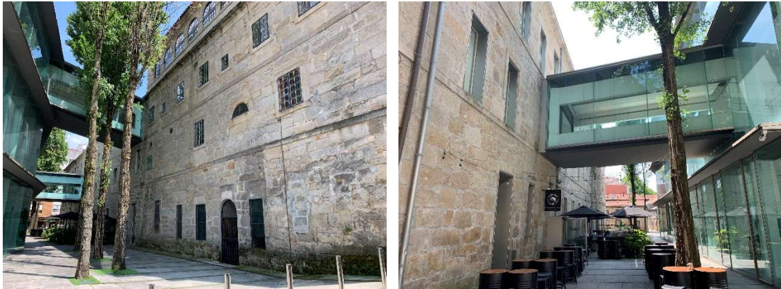
Figura 108-109. Fotografías pasarelas de comunicación entre ambos inmuebles.
