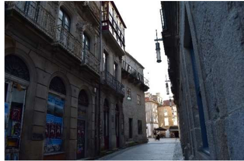
Figura 162. Vista exterior del estado actual del inmueble.
