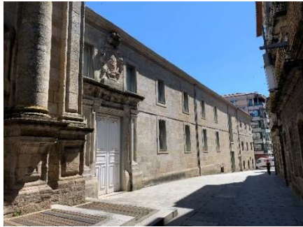
Figura 181. Vista exterior del estado actual del inmueble.
