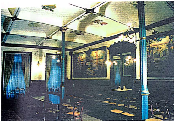
Figura 50. Vista interior Café Moderno previa intervención.
