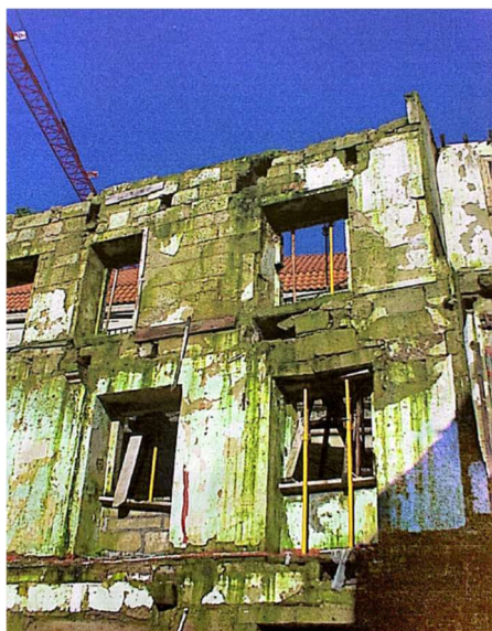
Figura 148. Estado de la fachada tras el vaciado.
