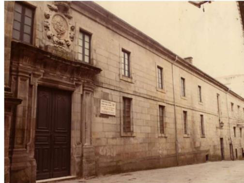
Figura 90. Fachada calle Sarmiento año 1965.
