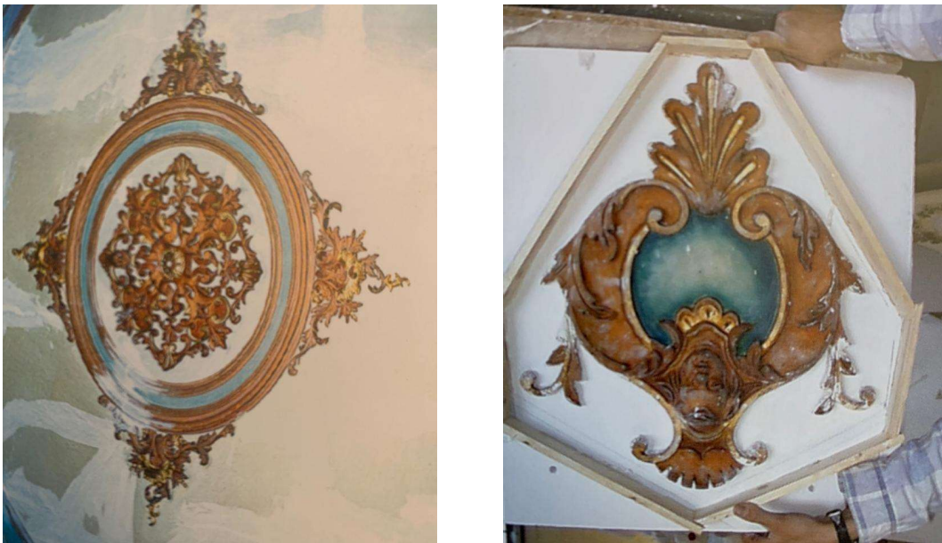
Figura 54-55 Moldura en proceso de restauración / Molde para copia de moldura.
