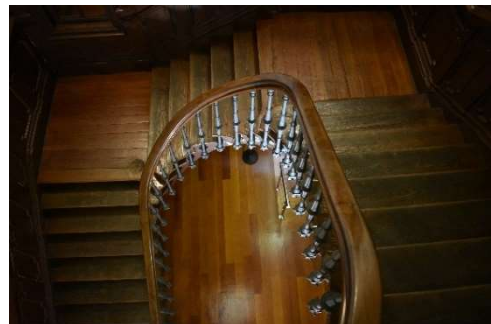
Figura 141. Vista interior del estado de las escaleras conservadas.
