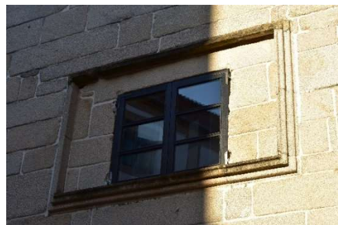
Figura 164. Detalle del recercado de piedra de las ventanas.
