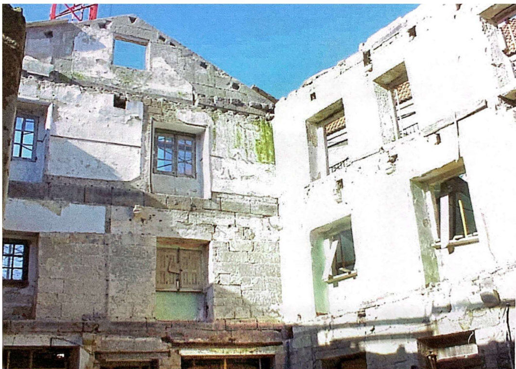
Figura 83. Vaciado interior del inmueble.
