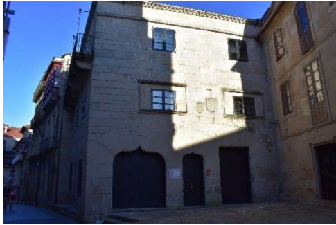
Figura 161. Vista exterior del estado actual del inmueble.
