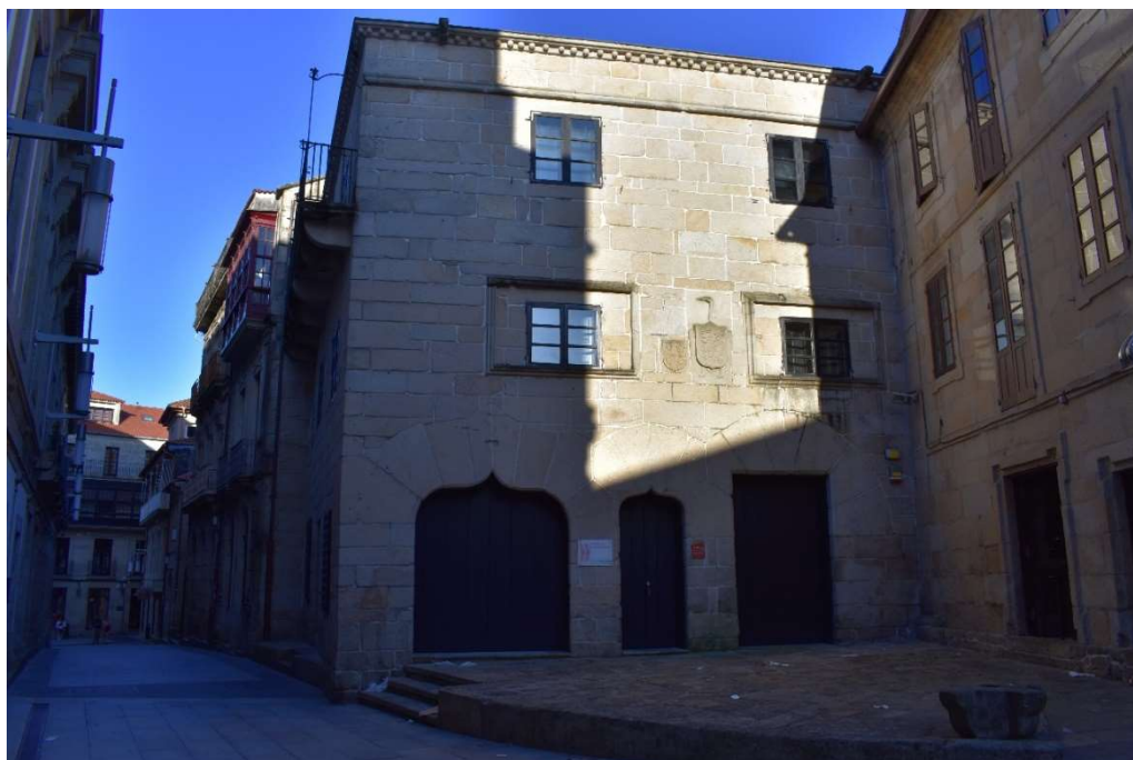
Figura 64. Fachada principal con plazoleta en el frente.
