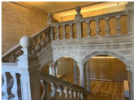
Figura 185. Vista interior escaleras de piedra.
