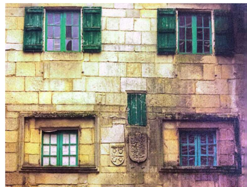
Figura 74. Antigua fachada del edificio.
