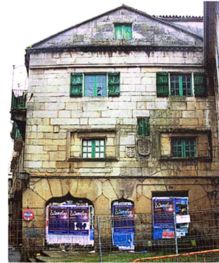
Figura 72. Antigua fachada del edificio.
