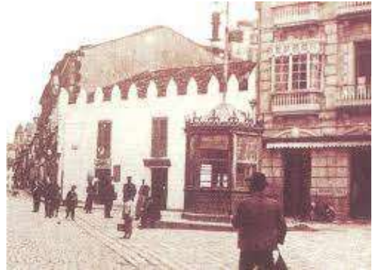
Figura 44. Fachada plaza San José.
