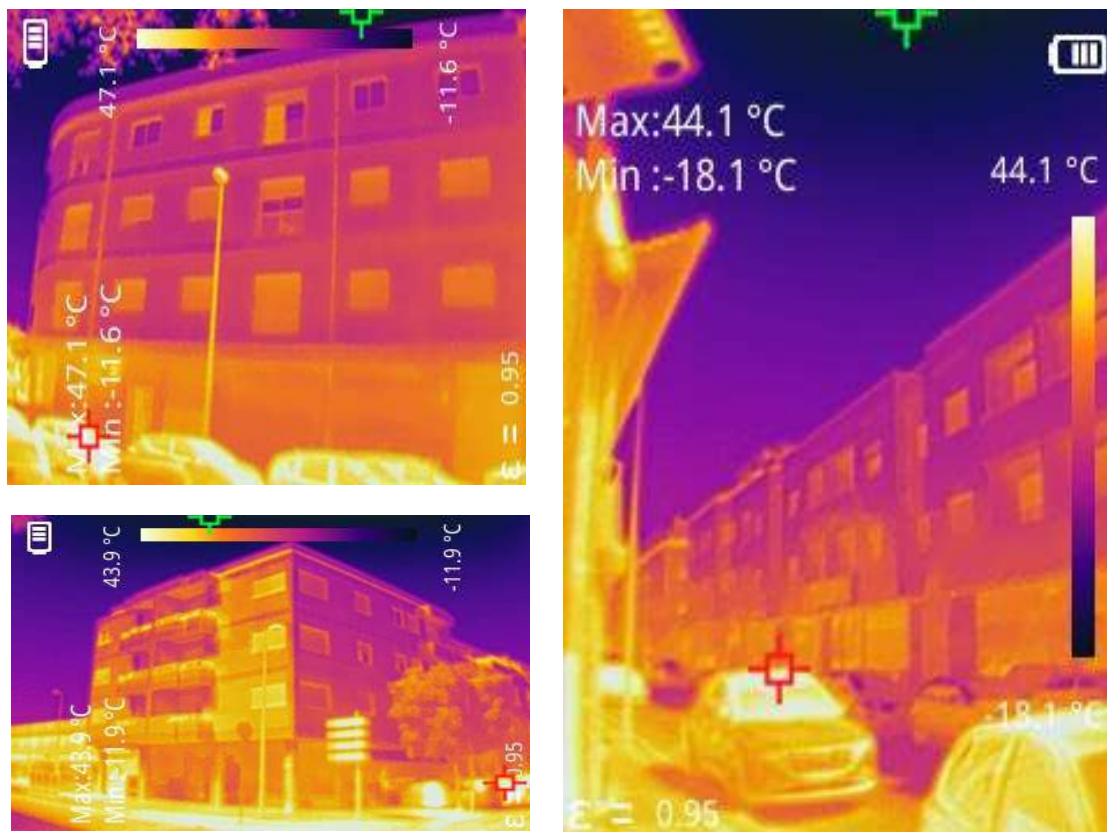
Figura 60 -Estudo de Caso 2 e 3 - Termografia Fonte: Autor
