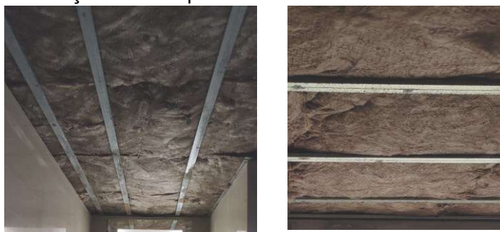
Colocação de XPS pelo interior
