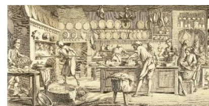
Figura 13. Vista interior de una cocina Fuente: Blasco (2006), p. 81.
