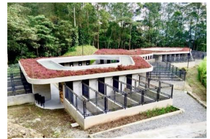
Patios. Fuente: V2 Arquitectura.
