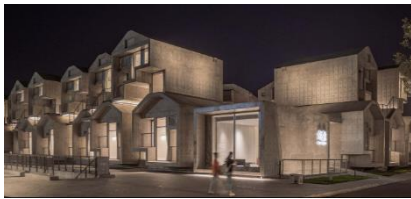
Fachadas principales. Fuente: ArchDaily.
