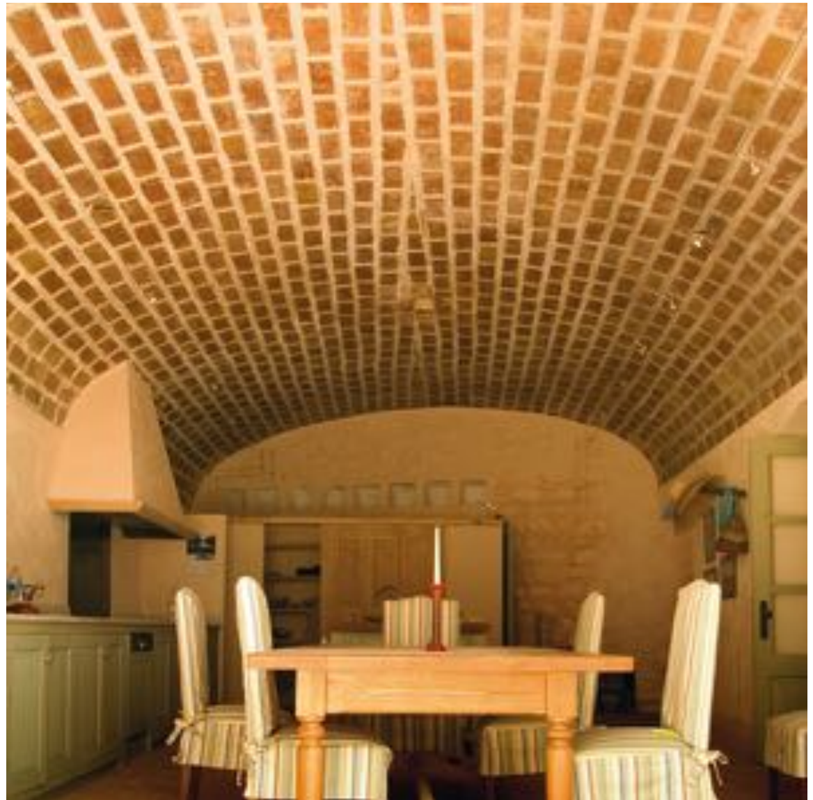
Volta de maó pla Font: Medir Cucurull
