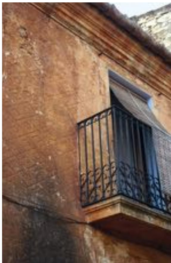
Façana tradicional de calç Font: Oriol Roselló
