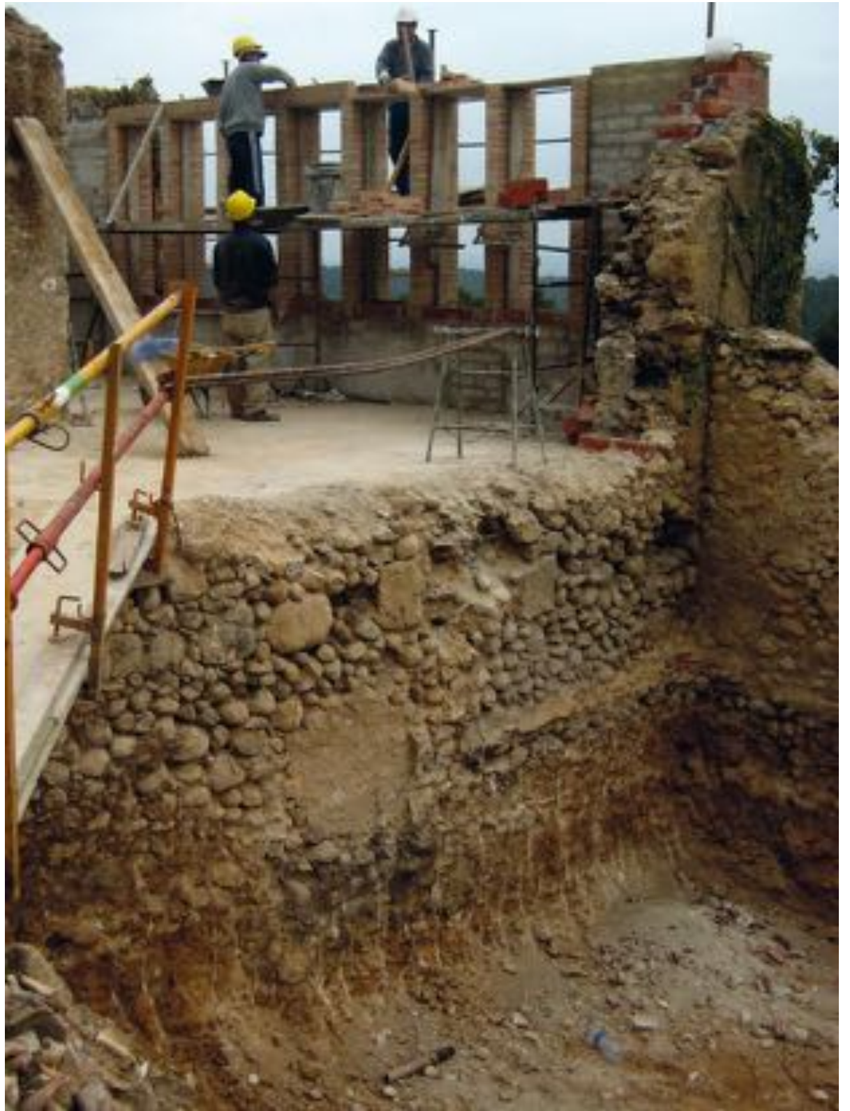
Excavació del subsòl Font: Oriol Roselló
