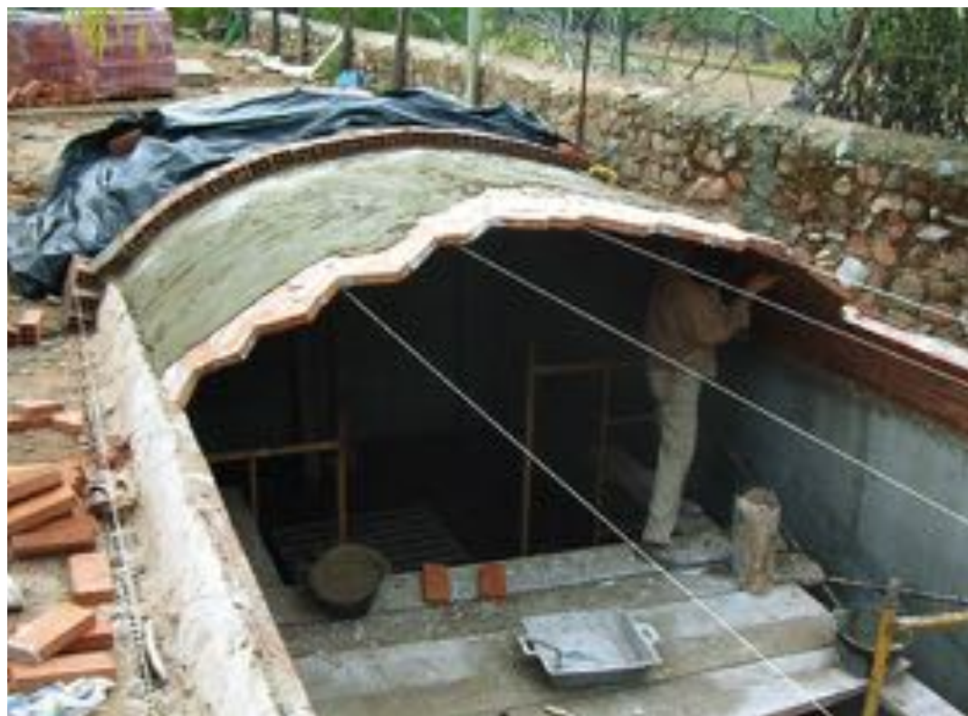
Procés d'execució d'una volta Font: Manuel Fortea
