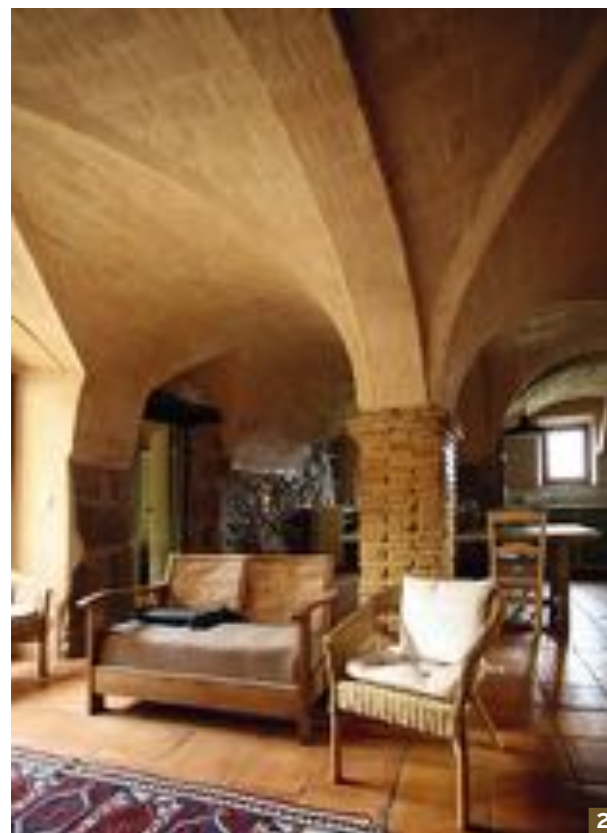
2. Volta catalana des de l'interior Font: Oriol Roselló
